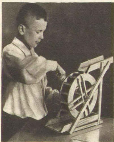
Изготовление деревянного верхнебойного колеса.
