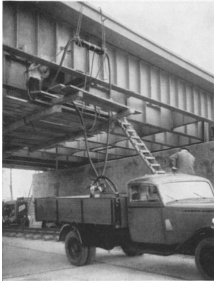
Abb. 93. Schweißnahtprüfung an einer Straßenbrücke (Berthold).
