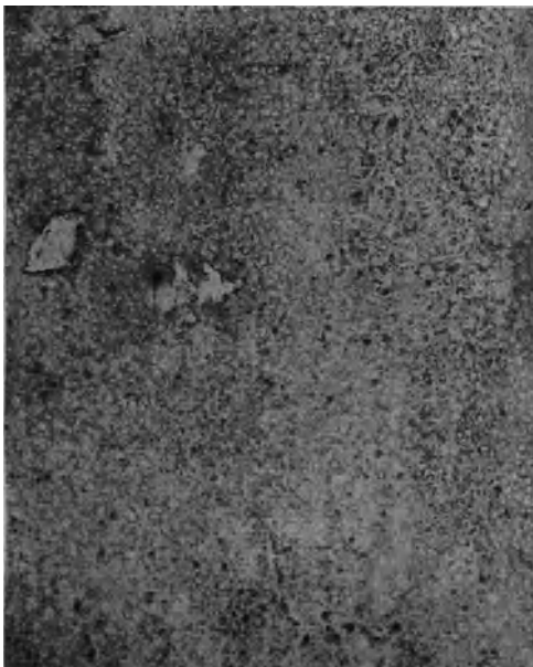
Abb. 1956. Mit Sandstrahl entrostet. Vor dem Anstrich im Freien gelagert, so gut wie möglich abgetrocknet.
