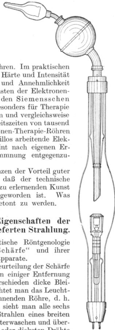
Abb. 59. Elektronen-Therapie-röhre (C. H. F. Müller.)
