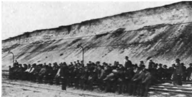
Abb. 5. Gleisrücken von Hand.
