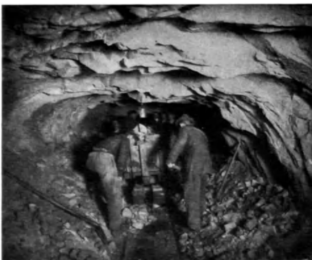
Abb. 9. Laden von Hand im Stollen. (Ausführung: Siemens-Bauunion, Berlin.)
