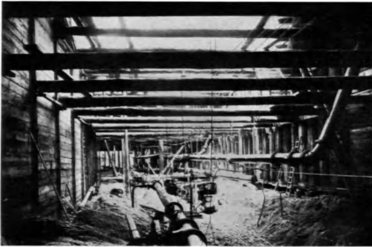
Abb. 62. Grundwasserabsenkung beim Bau einer Untergrundbahn. (Siemens-Bauunion, Berlin.)
