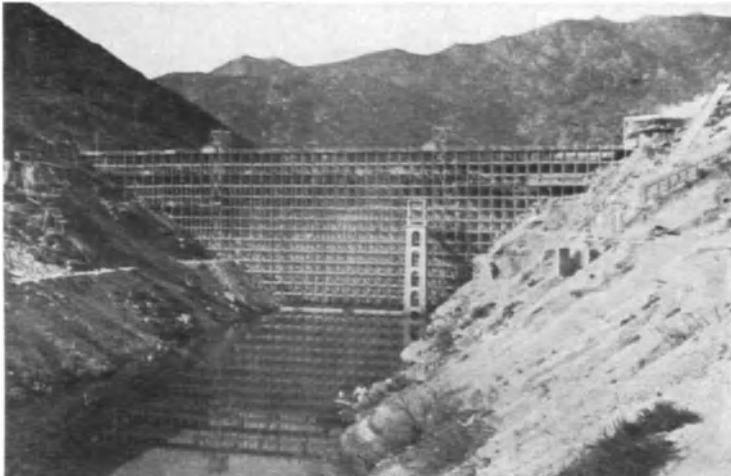
Abb. 25. Hölzerne Brücke für den Bau der Talsperre Coghinas (Sardinien).
