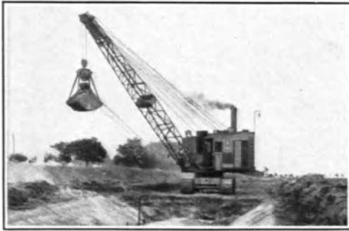
Abb. 71. Löffelbagger, als Greifer umgebaut. (Menck & Hambrock G. m. b. H., Hamburg.)
