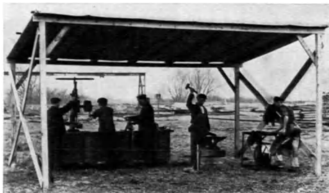
Abb. 199. Provisorische Werkstatt einer kleinen Hochbaustelle.
