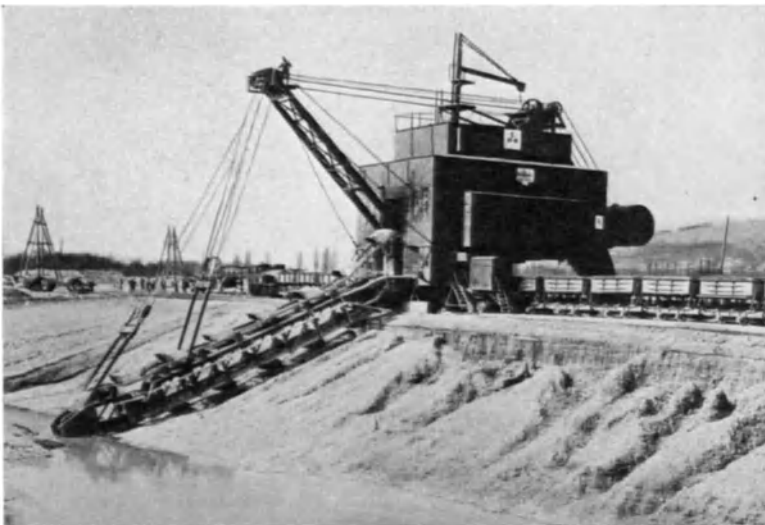
Abb. 68. Eimerkettenbagger mit 750 Ltr. Eimerinhalt beim Bau der Wasserkraftanlage Kembs a. Rh. (Lübecker Maschinenbau-Gesellschaft, Lübeck.)
