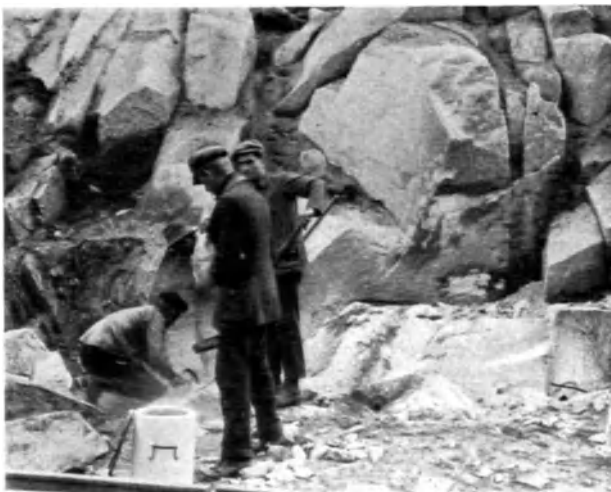
Abb. 91. Einbringen der Patronen in die Bohrlöcher.
