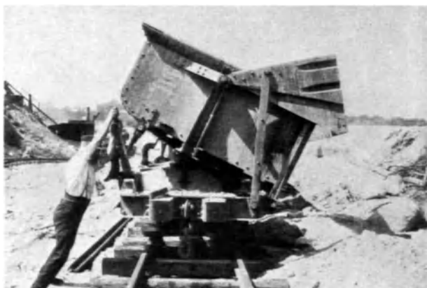
Abb. 4. Kippen bei Verwendung von Selbstkippern.
