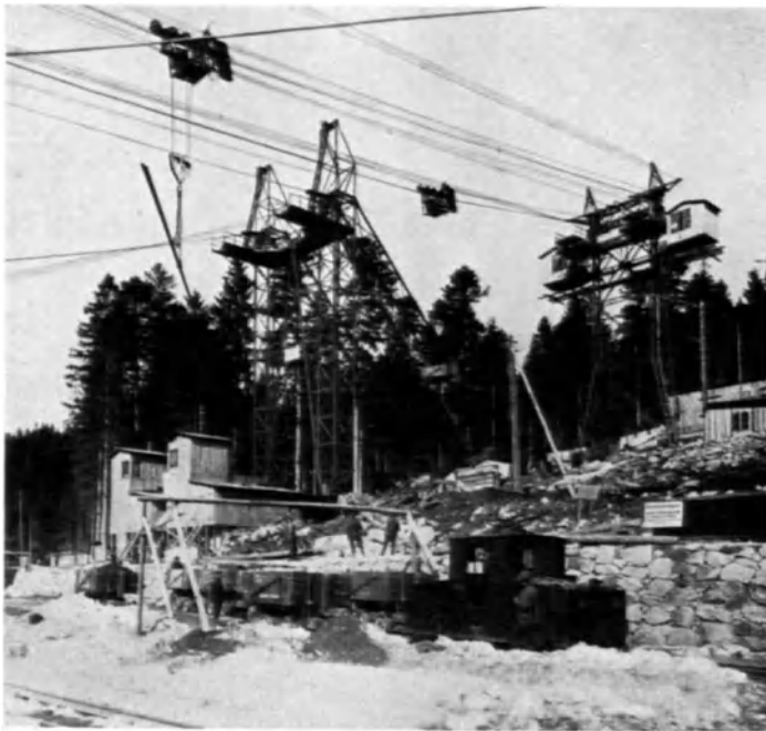
Abb. 45. Feststehende Kabelkrantürme beim Bau der Schwarzenbach-Talsperre.
