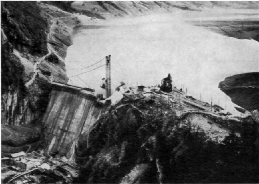
Abb. 112. Gießanlage beim Bau der Staumauer Wäggital (Gießrinnen am aufgehängten Drahtseil.) (Int. Baumaschinen-A.-G., Neustadt a. d. H.)
