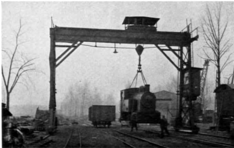
Abb. 300. Fahrbarer Bockkran (Siemens-Bauunion, Spandau).
