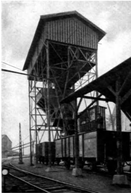
Abb. 28. Becherwerk für das Ausladen aus Eisenbahnwaggons. (Heinzelmann & Sparmberg, Hannover.)
