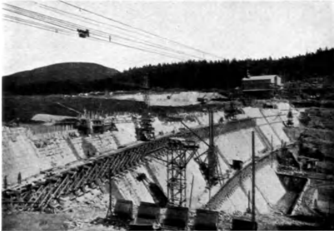
Abb. 8. Betonierung einer Sperre. (Schwarzenbachtalsperre.) (Ausführung: Siemens-Bauunion, Berlin.)
