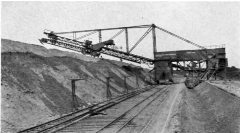
Abb. 77. Absetzer beim Schütten der Dämme der Wasserkraftanlage am Shannon (Irland).
