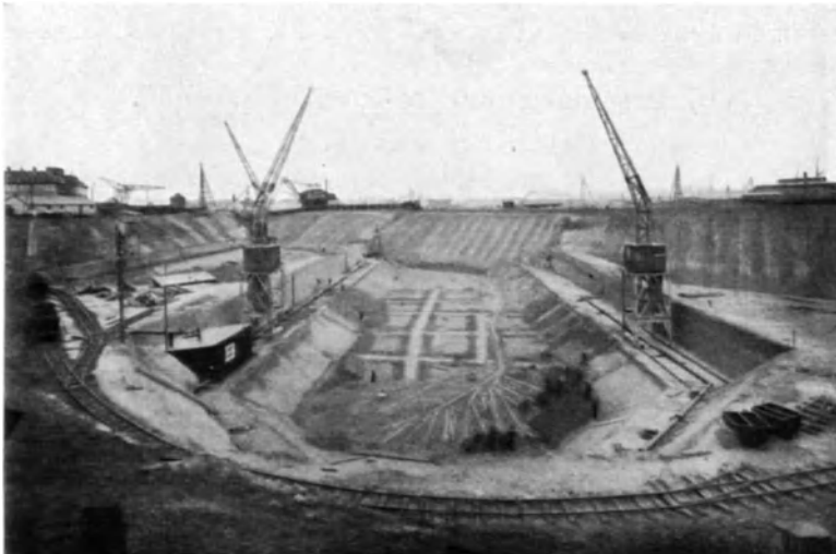
Abb. 63. Grundwasserabsenkung beim Bau der Schleuse Antwerpen. (Siemens-Bauunion, Berlin.)
