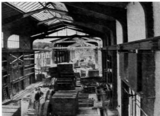
Abb. 204. Baukraftwerk und Montagehalle Irland.
