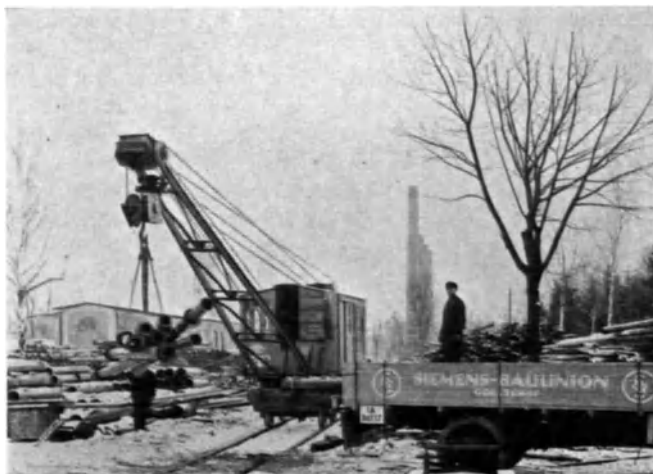
Abb. 298. Rohöllokomotivdrehkran (Siemens-Bauunion, Spandau).
