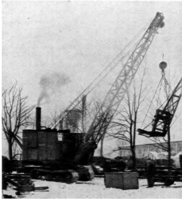
Abb. 299. Rohölraupenkran (Siemens-Bauunion, Spandau).
