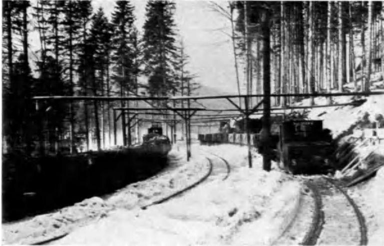
Abb. 30. Oberleitung bei elektr. Lokomotivbetrieb. (Verbindungsbahn Steinbruch—Sperrbeim Bau der Schwarzenbach-Talsperre.)
