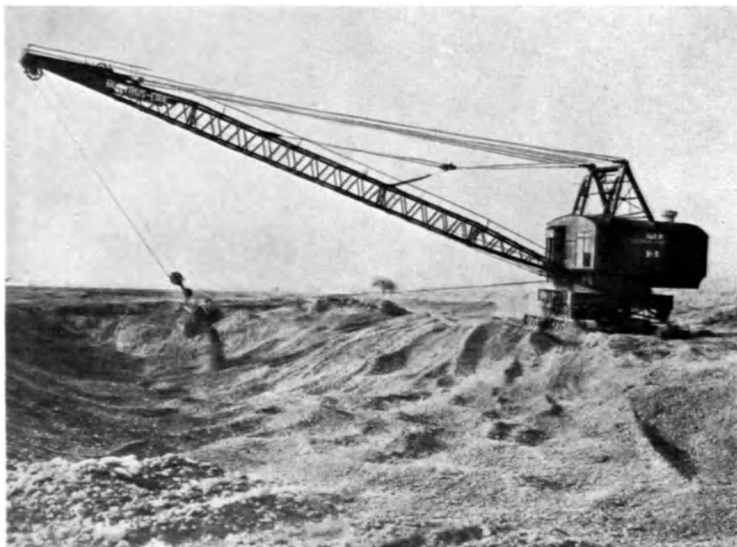
Abb. 74. Eimerseilbagger beim Bau der Wasserkraftanlage Kembs a. Rh. (Bucyrus Erie Co.)
