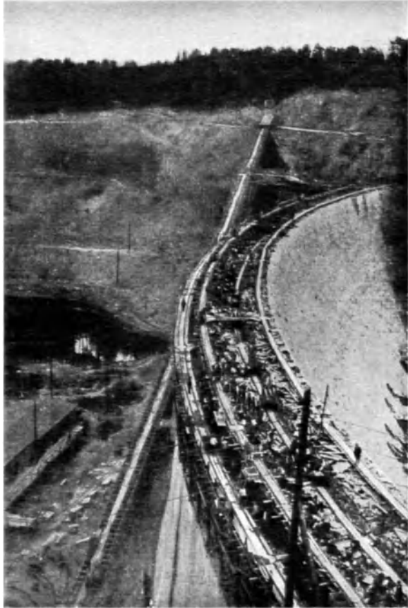
Abb. 7. Mauerung einer Sperre. (Talsperre Mauer i. Rsgb.) (Aus Cucchiero: Die Hochwasserschutz-Talsperre bei Mauer i. Rsgb.)
