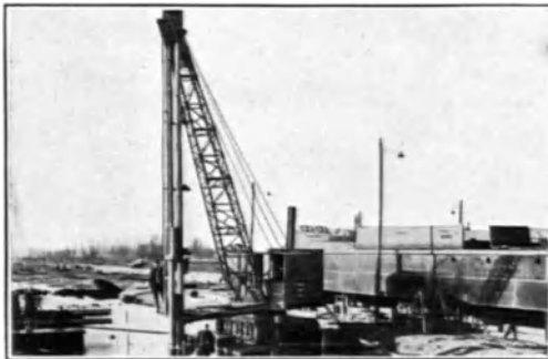
Abb. 72. Löffelbagger, als Ramme umgebaut. (Menck & Hambrock G. m. b. H., Hamburg.)
