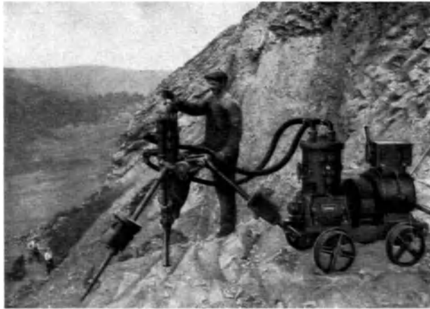
Abb. 84. Elektro-pneumatische Bohrmaschine. (Deutsche Maschinen-Fabrik A.-G., Duisburg.)
