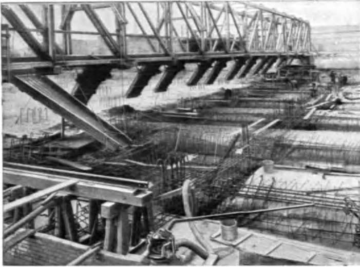
Abb. 135. Hafenspeicher Stettin. (Holzbrücke für die Betonierung.)
