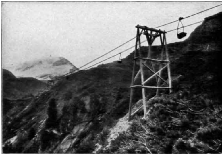
Abb. 41. Seilbahn beim Bau der Talsperre Vermunt (Österreich).
