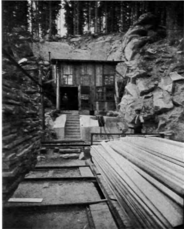
Abb. 37. Obere Endstation des Schrägaufzuges für den Bau der Schwarzenbach-Talsperre.
