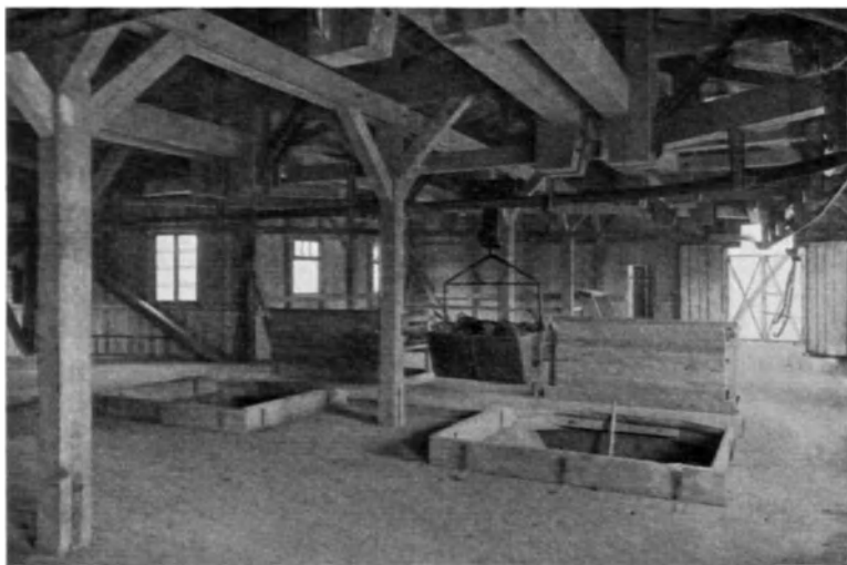
Abb. 48. Hängebahn in einer Aufbereitungsanlage. (Krupp-Grusonwerk, Magdeburg.)
