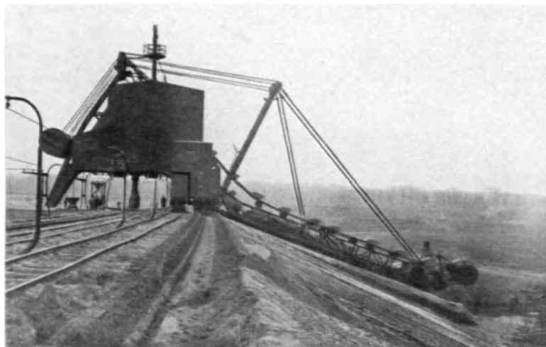
Abb. 66. Eimerkettenbagger der Lübecker Maschinenbau-Gesellschaft, Lübeck, (Doppelschütter) mit 550 Ltr. Eimerinhalt, elektr. Antrieb.
