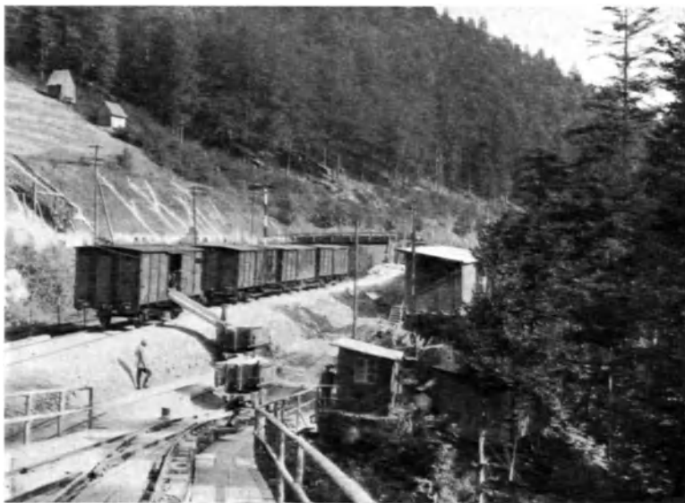
Abb. 26. Umladebahnhof Raumünzach für den Bau der Schwarzenbach-Talsperre. (Ausführung: Siemens-Bauunion, Berlin.)
