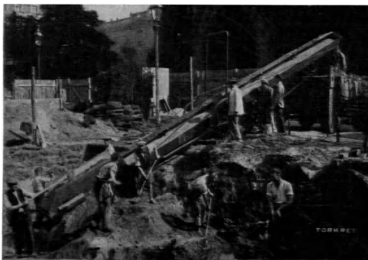
Abb. 51. Geneigtes Förderband beim Erdaushub. (Torkret G. m. b. H., Berlin.)
