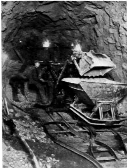
Abb. 10. Laden mit Maschinen im Stollen. (Schauffellader der „Demag“ im Eichholzstollen des Schluchseewerkes.) (Ausführung: Siemens-Bauunion, Berlin.)
