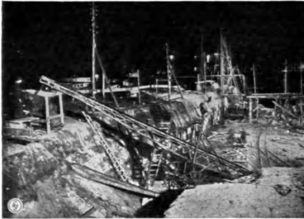
Abb. 119. Baustelle bei künstlicher Beleuchtung.
