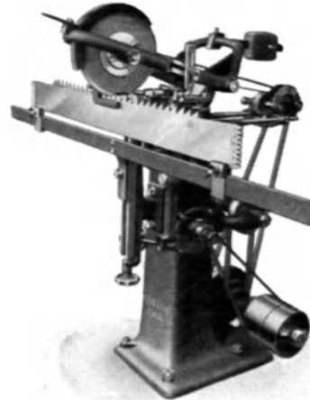
Abb. 257 a. Spiralbohrerschleifmaschine.
