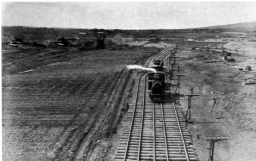
Abb. 6. Gleisrücken mit Maschinen. (Baustelle Shannonkraftwerk Irland.) (Ausführung: Siemens-Bauunion, Berlin.)
