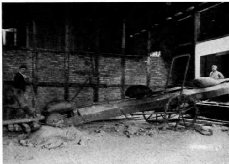
Abb. 29. Fahrbare Bänder für den Transport von Säcken. (Torkret-Gesellschaft m. b. H., Berlin.)
