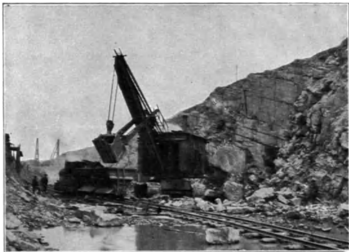
Abb. 70. Raupenlöffelbagger im Felsbetrieb. (Menck &amp; Hambrock G. m. b. H., Hamburg.)
