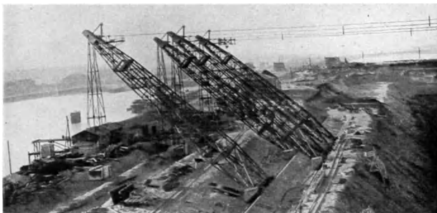
Abb. 46. Kabelkrane mit Pendeltürmen.
