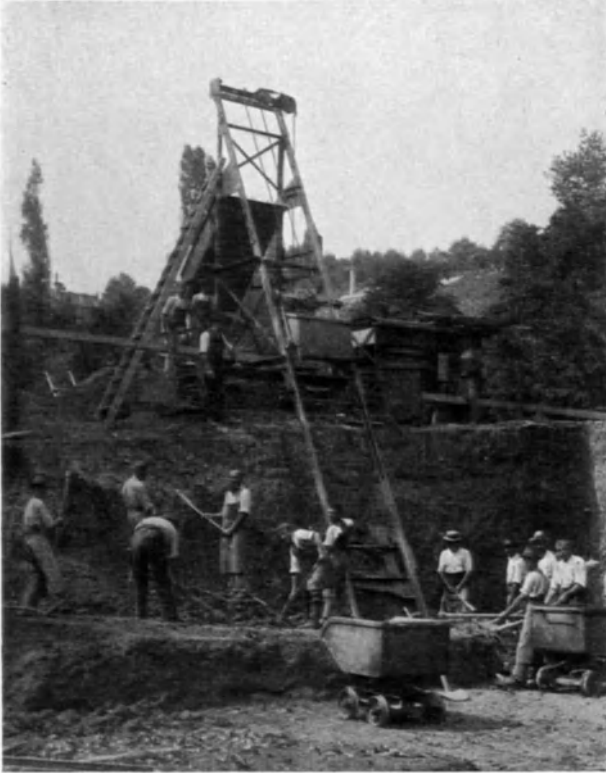
Abb. 56. Baugrubenaufzug. (Karl Peschke, Zweibrücken.)
