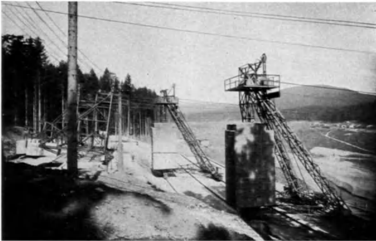
Abb. 44. Fahrbare Kabelkrantürme beim Bau der Schwarzenbach-Talsperre.
