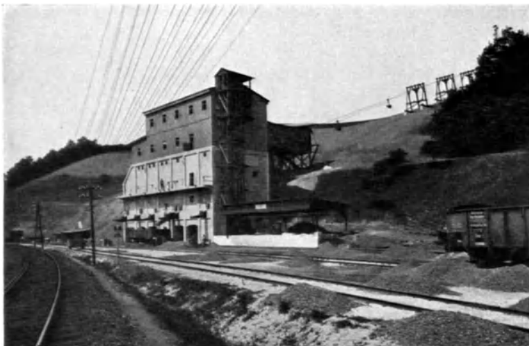
Abb. 60. Siloanlage. (Krupp-Grusonwerk, Magdeburg.)
