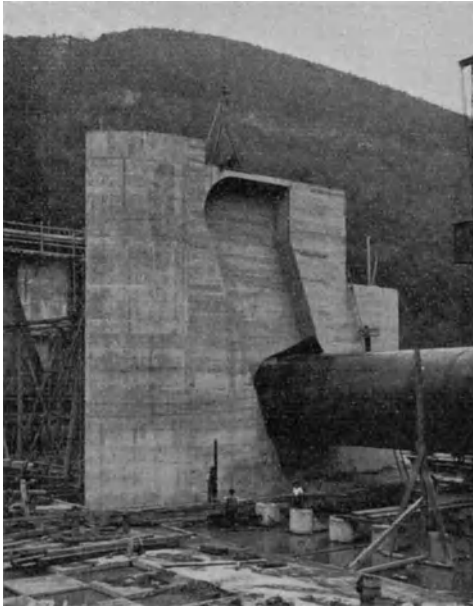
Abb. 17. Wehrpfeiler aus plastischem Beton.
