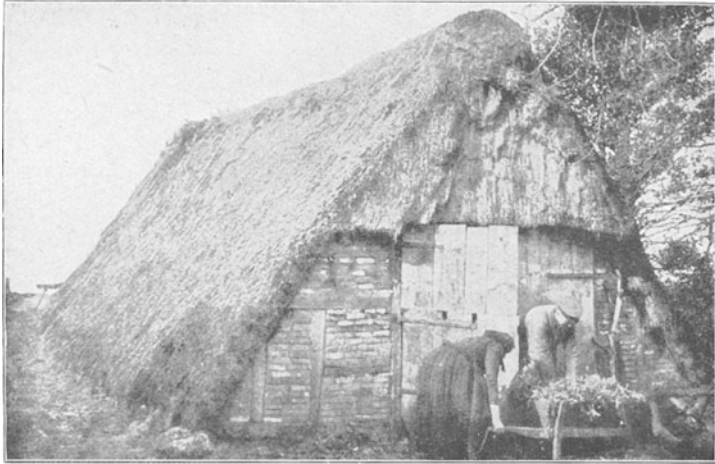
1. Dachhütte, Urform des niederländischen Hauses, heute noch vielfach für Stallungen verwendet (Schafstoben in der Lüneburger Heide).
