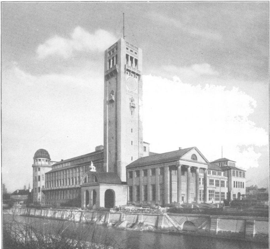
2. Das Deutsche Museum von Meisterwerken der Naturwissenschaft und Technik in München. Bau der Neuzeit, der aber verschiedene ältere Stilformen benutzt.
