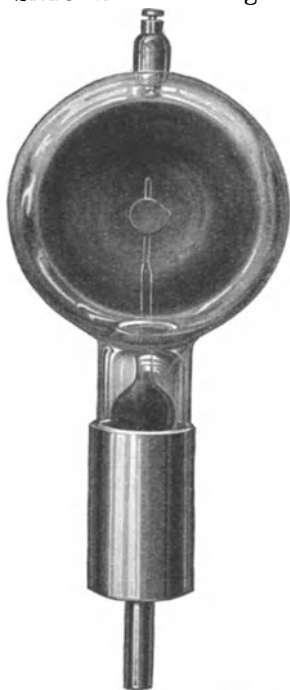
Abb. 274. Großflächige AEG-Photozelle ( \frac{1}{2} nat. Größe).
