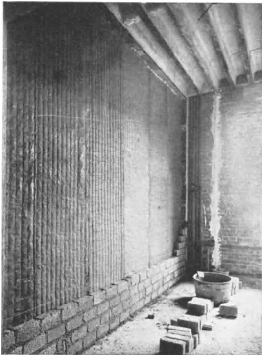
Abb. 15. Herstellung einer schalltechnischen Doppelwand, bestehend aus 2 \times \frac{1}{4} Stein Schwemmsteinmauerwerk und zwischenhängender Bitumenisiermatte (Zostamatte).
