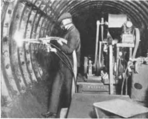
Abb. 28. Ausspritzen des Tunnels einer Untergrundbahn mit Asbest.
