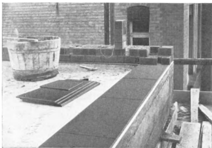
Abb. 1. Schalldämmung des aufgehenden Mauerwerks mit Jute-Bitumen-Preßplatten.
