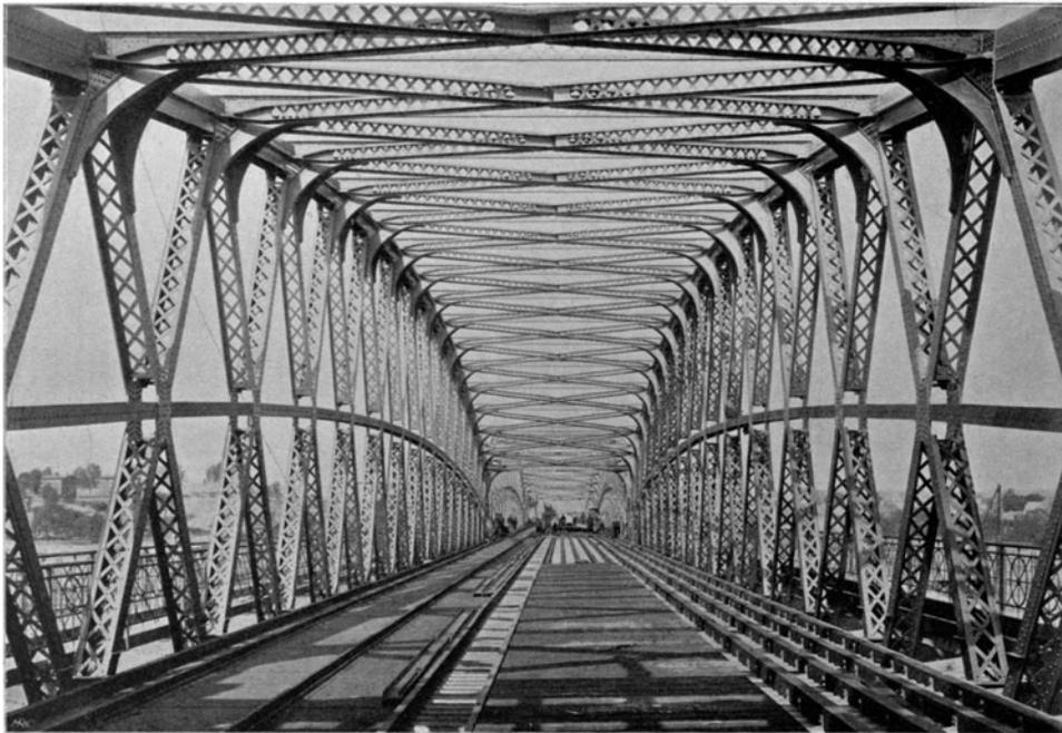
Josef Langer, ein erfinderischer, seiner Zeit in seinen Ideen vielfach verkannter Ingenieur, hat zuerst versucht, einen durchgehenden Träger durch einen darüber liegenden Hängegurt derartig zu versteifen, dass dessen Horizontalschub aufgehoben wird. Seine Wrsowicer Brücke in der Franz-Josephsbahn zeigte eine solche zusammengesetzte Balkenkonstruktion, die den Eindruck einer Hängebrücke macht (Abb. 33). Langer selbst nennt sie eine „Steife Ketten-
