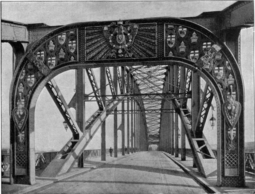
gurten liegt. Für den oberen Windverband werden die Gurte durch die Obergurte der Hauptträger und die Wandglieder durch die Buckelplatten gebildet. Für den unteren Verband sind Querriegel und Windstreben angeordnet.
