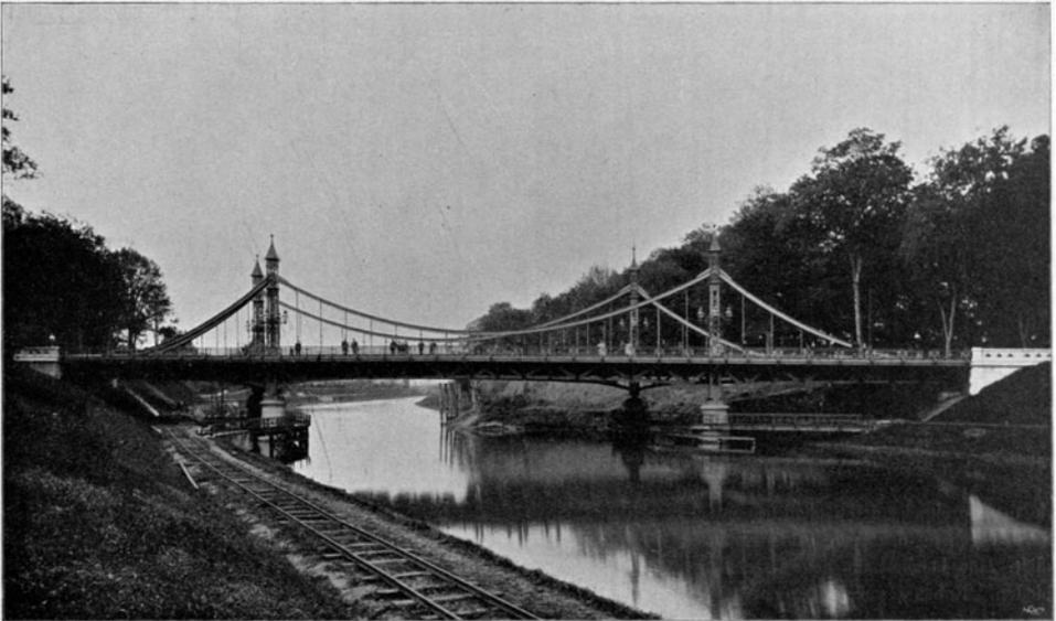
kommenden Anordnungen hat der aus seiner Ebene gebrachte Girlandenträger das Bestreben, sich wieder senkrecht zu stellen, weil der Schwerpunkt des Trägers unterhalb der Verbindungslinie seiner Stützpunkte liegt. Die Quersteifigkeit der Konstruktion wird erzielt durch steife Hängerahmen in Verbindung mit dem unter der Fahrbahn befindlichen Hauptwindverbände, der wie die Hauptträger ein auf vier Stützen durchlaufender Balken ist.
