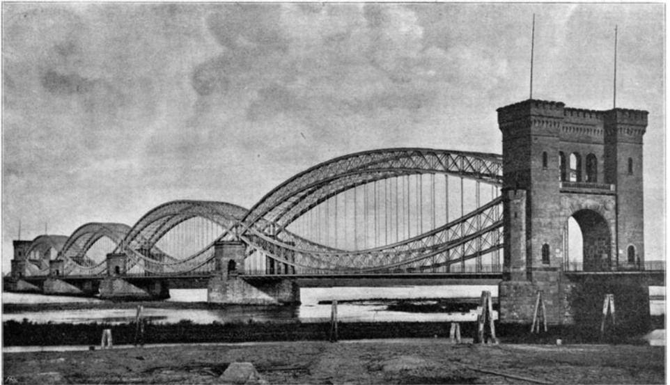
an die Nothwendigkeit der Gelenke erschüttert hat. Hervorragende neuere Ausführungen von gegliederten Bogen-trägern ohne Gelenk sind: Die 1881-82 gebaute 114 m weite Schwarzwasser-Brücke in der Strasse von Bern nach
