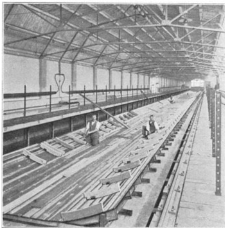
Fig. 35. Befestigung der Holzböschungen auf das Muldenprofil.
