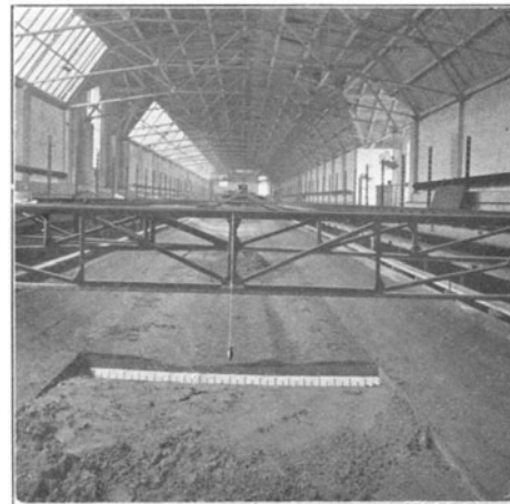
Einwirkung der Schraube auf die mit Kies bedeckte Sohle des Modells des Großschiffahrtsweges Berlin-Stettin nach 3510 Fahrten bei 808 Uml./min der Schraube. Kies von 1,75 bis 2,65 mm Korngröße. Fig. 60. Bedeckungstiefe 15 mm. Fig. 61. Bedeckungstiefe 25 mm.
