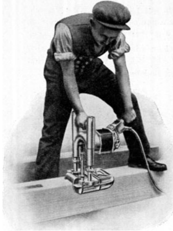
Abb. 55. Elektrischer Handkettenstemmaapparat, zum Zapfenlochstemmen eingerichtet. Fräskette mit unten runder Führung.
