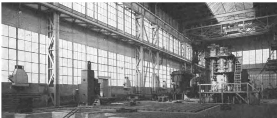
Abb. 84. Dieselmotor-Rüsthalle der Firma Gebrüder Sulzer A.-G., Winterthur, mit Heizrohren und Einzelluft-erhitzern an den Außenwänden.
