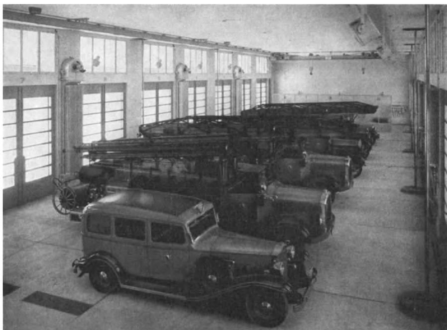
Abb. 85. Gerätehalle der neuen Brandwache in Zürich mit lotrecht stehenden Heizregistern und Einzelluftheizern, die die Luft durch hinter den Heizregistern liegende Kanäle vom Boden her ansaugen und oben erwärmt ausblasen.
