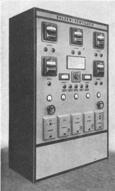
Abb. 55. Schalttafel der Klimaanlage eines Verwaltungsgebäudes.
