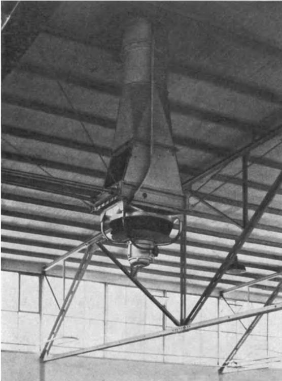
Abb. 83. Einzellufterhitzer an der Decke einer hohen Halle.
