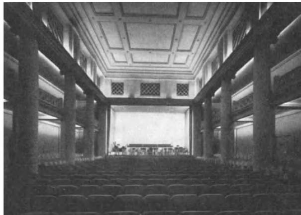
Abb. 73. Konzertsaal im Stadthaus Winterthur. Die Zuluft wird mit großer Geschwindigkeit waagrecht durch die rings um die Deckenfelder laufenden Luftschlitze eingeblasen.
