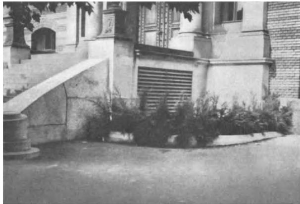
Abb. 31. In ein bestehendes Gebäude nachträglich eingebaute Frischluftentnahme.
