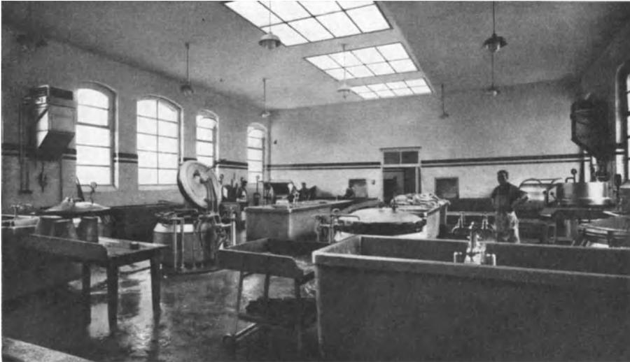
Abb. 125. Durch Einzellüfter geheizter, gelüfteter und entnebelter Kutteleiraum in einem Schlachthof. Jeder der beiden an den Seitenwänden angebrachten Luftherziger liefert  $4100 \text{ m}^3/\text{h}$  Luft und weist eine Wärmeleistung von  $104000 \text{ kcal/h}$  auf. Die Abluft entweicht z. T. durch den anstoßenden Wampentleerraum, z. T. durch geöffnete Fensterflügel. Zeitweise wird sie auch durch Deckenöffnungen abgesaugt und ins Freie geblasen.
