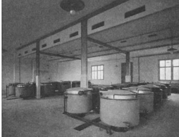
Abb. 122. Volksküche mit Lüftungs- und Entnebelungsanlage.
