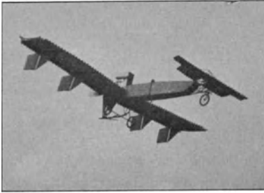
Fig. 21. Längsstabilisierung durch Kopfflosse. Reißner.
