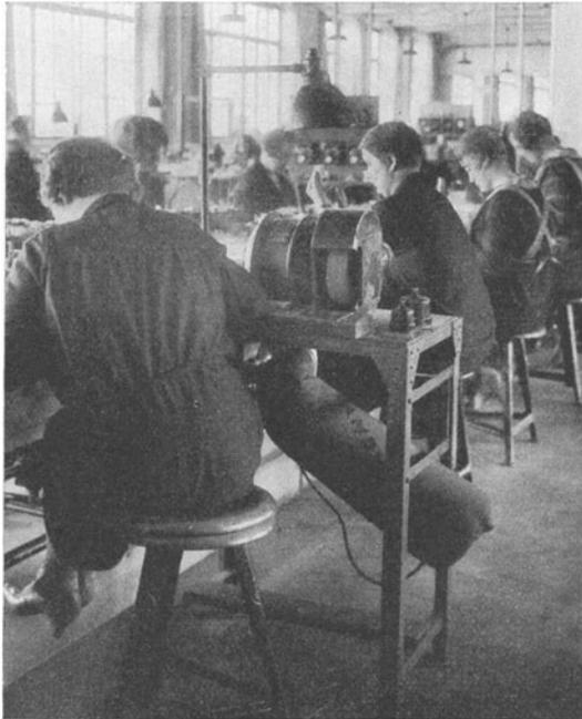
Abb. 20. Der Drehschemel ermöglicht der Arbeiterin Mikroskop-Beobachtung und, nach einer Rechtsschwenkung, Schleifarbeit an der Schwabbelscheibe. Beachte die Staubabsaugung durch Staubsauger!
