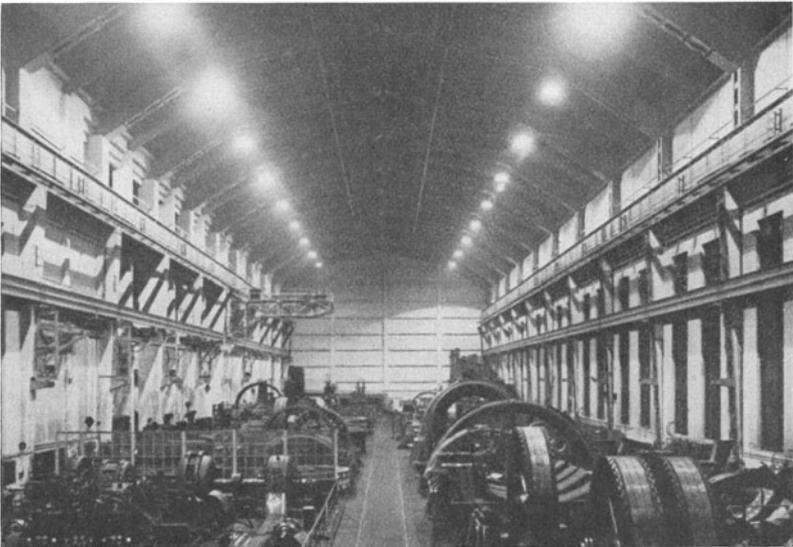
Abb. 7. Allgemeinbeleuchtung einer Montagehalle durch Tiefstrahler.
