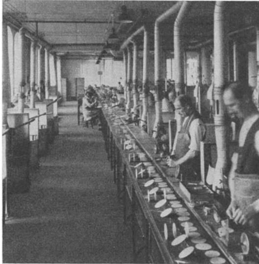
Abb. 6. Spritzgußmaschinen frei im Raume in die Fließarbeit eingegliedert. Beachte die Abzugsrohre!
