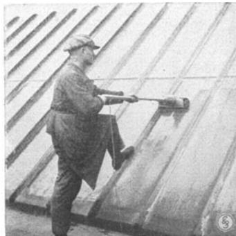
Abb. 6. Protos-Bohner zur Entstaubung und Reinigung von Shed-Dächern.
