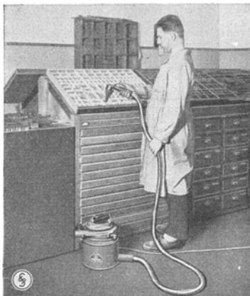
Abb. 4. Setzkastenreinigung in Druckerelen im Betrieb.
