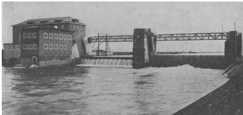
Abb. 13. Walzenwehr im Main bei Viereth.
