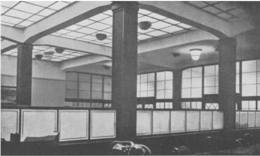
Abb. 51. Belüftung eines Büros durch Anemostaten.
