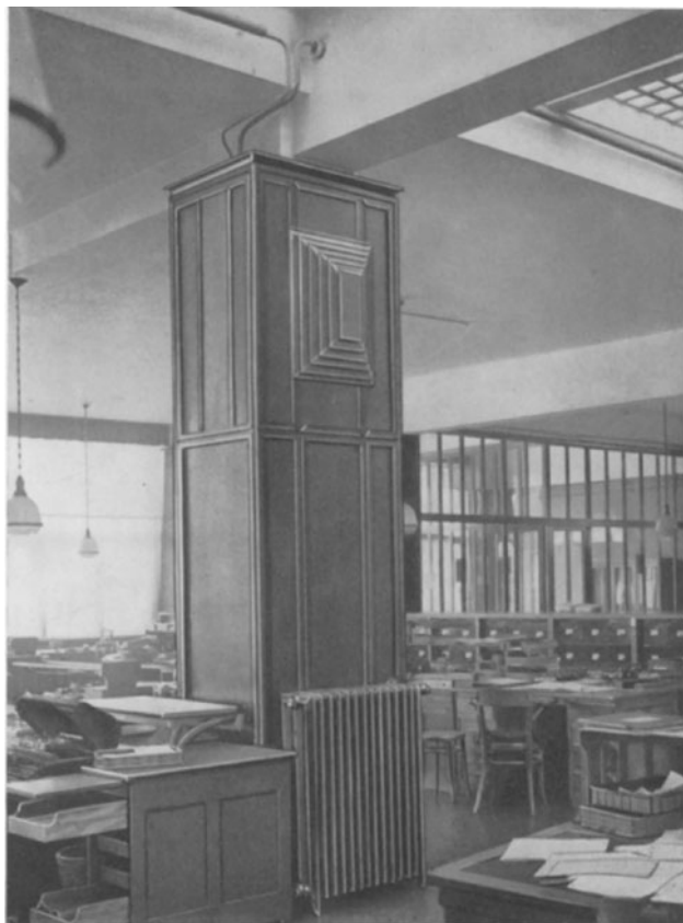
Abb. 80. Luftverteiler im Büro.
