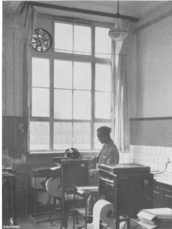
Abb. 83. Schraubenlüfter in einer Kleinwerkstatt.
