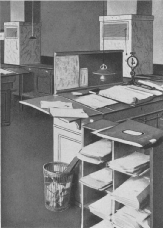
Abb. 81. Zuluftöffnungen in den Pfeilern.
