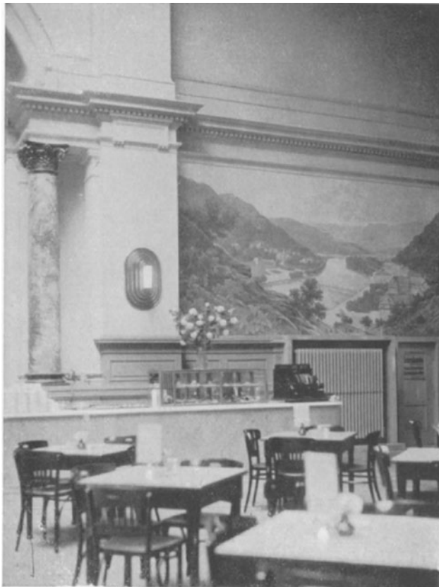
Abb. 90. Luftzuführung mittels Luftverteiler am Beleuchtungskörper.
