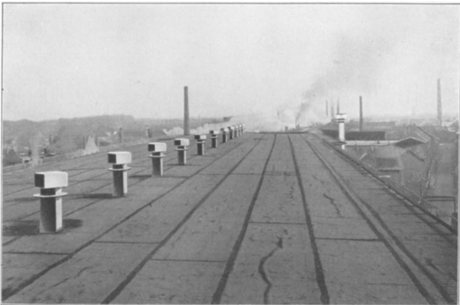
Abb. 26. Entlüftung mittels „Kubo-Stator“-Saugers.
