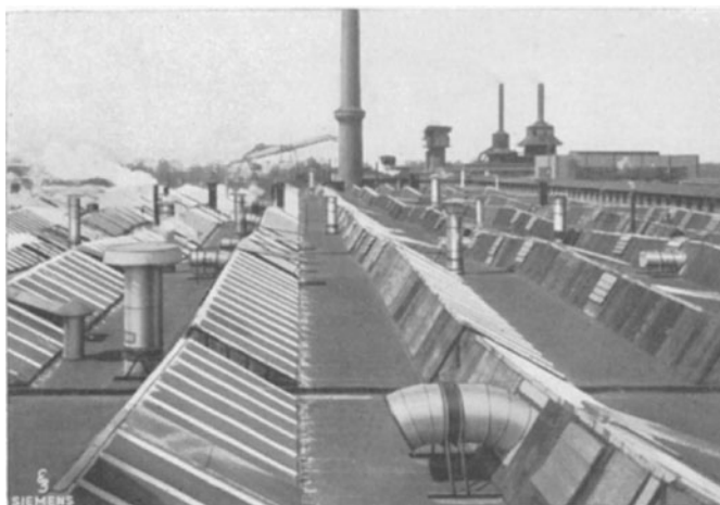
Abb. 41. Hochdruck-Schraubenlüfter im Abluftrohr auf dem Dache.
