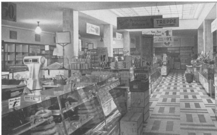
Abb. 71. Lüftung in der Lebensmittelabteilung eines Warenhauses.
