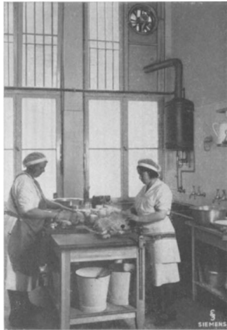
Abb. 86. Entlüftung in einem Gemüseputzraum.
