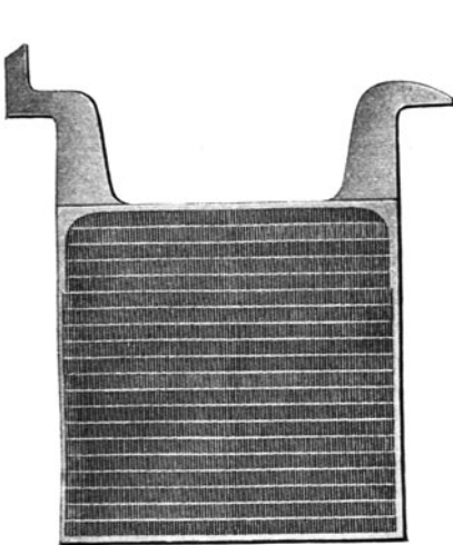
Abb. 60 a. Groboberflächenplatte der Firma Hoppecke A.G.
