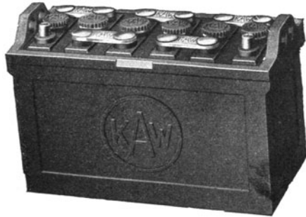
Abb. 101. Starterbatterie von 6 Zellen der KAW.
