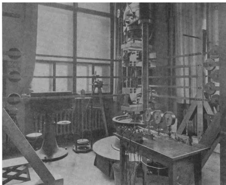
Abb. 18. Anordnung der Knickversuche.
