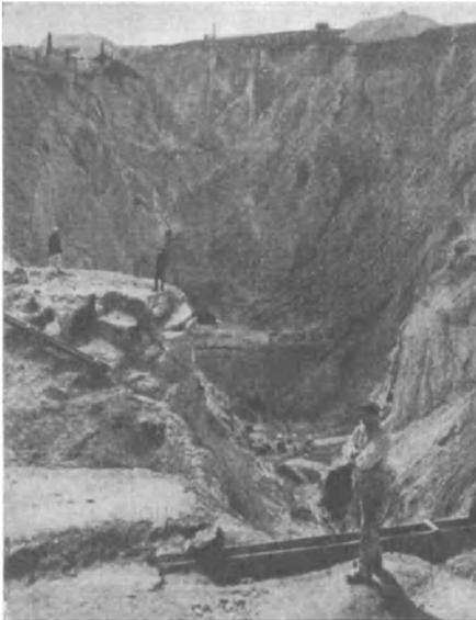
Abb. 6. Gewinnung von Kaolin nach dem Natur-Schlammverfahren in Cornwall, England<sup>2</sup>.
