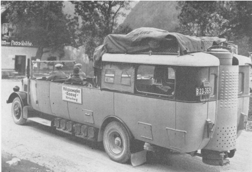
Abb. 44. Saurel-Omnibus (Wagen 56) mit Kromag-Holzgas-generator (eingebaut am Wagenende) während der österreichischen Sternfahrt 1934 nach Innsbruck am Paß Lueg
