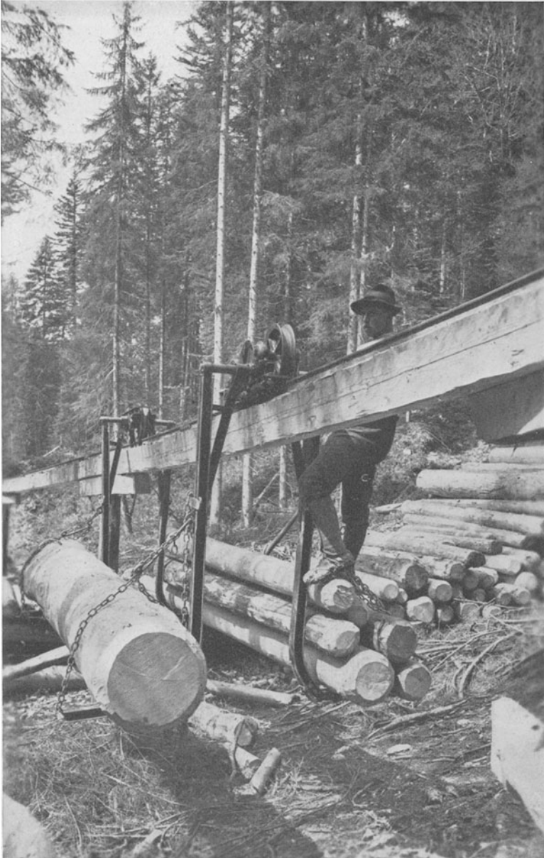
Abb. 29. Einschiennhängebahn mit zweiseitiger Aufhängung der Last (Bundesforst Achantal, Tirol)
