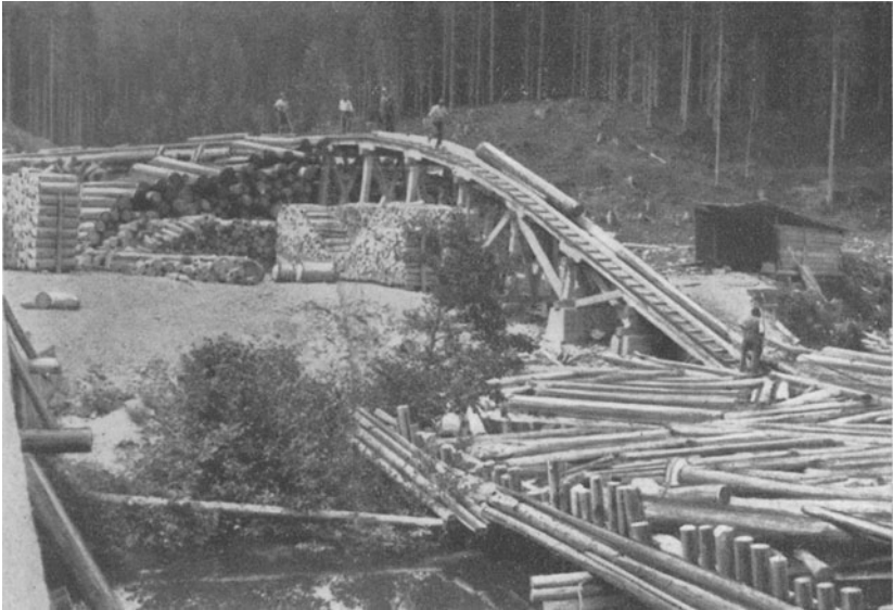
Abb. 35. Trift am Ampelsbach: Kögklauslände mit Kettenaufzug (Bundesforst Steinberg, Tirol)
