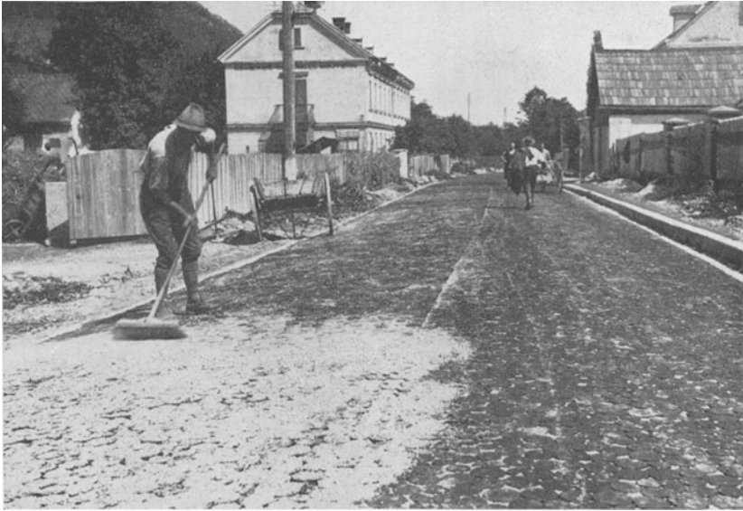
Abb. 76. Rundholzstöckelstraße in Mautern im Liesingtal (Steiermark): Absplitten der geteerten Straßenoberfläche
