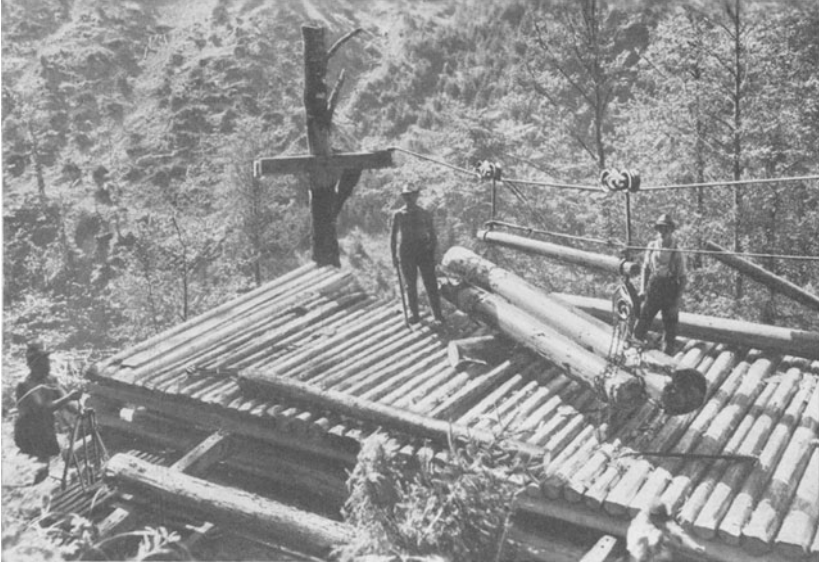
Abb. 14. Hängeseilaufzug, Beladestelle (Bundesforst Achantal, Tirol)
