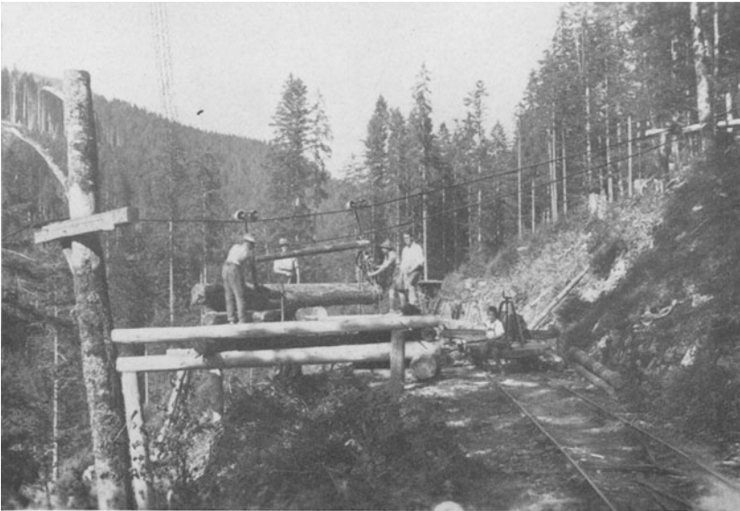
Abb. 15. Hängeseilaufzug, Entladestelle (Bundesforst Achantal, Tirol)
