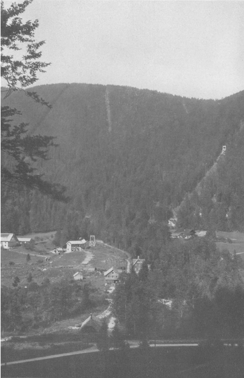
Abb. 23. Schöberlboden-Drahtseilriese; Übersicht. Im Vordergrund Waldbahn mit Abzweigung zum Lagerplatz unterhalb der Entladestelle der Seilriese (Ban .es-forst Hinteisee, Salzburg)
