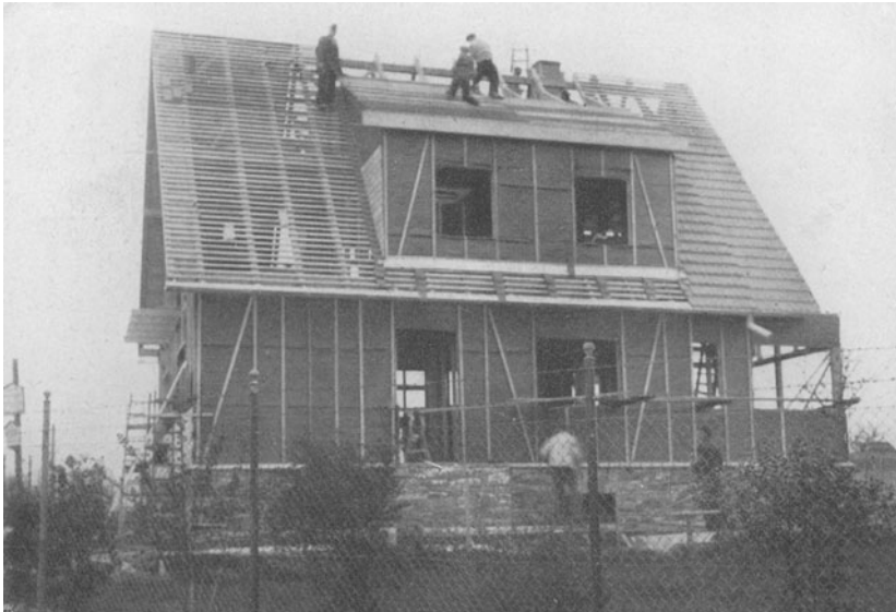
Abb. 67. Siedlungshaus in Holzskelettbauweise; 1 Woche nach Beginn des Zusammenbaues
