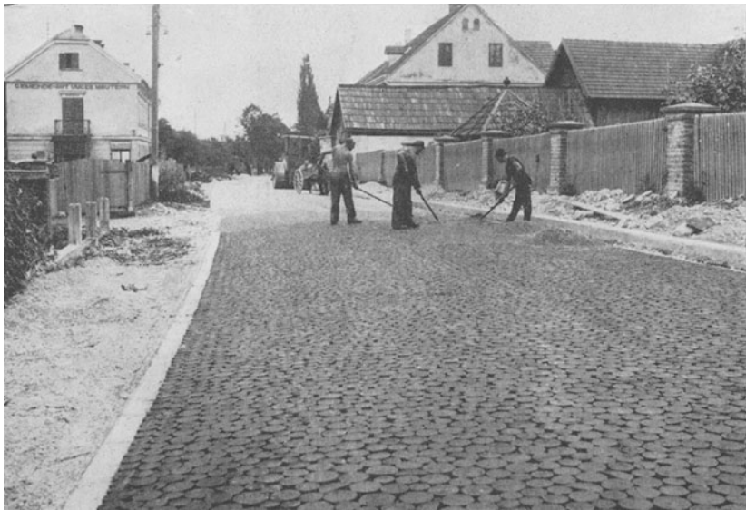
Abb. 77. Rundholzstöckelstraße in Mautern im Liesingtal (Steiermark); letzte Abdeckung der ganzen Straßenoberfläche mit Steinsplitt und Walzung
