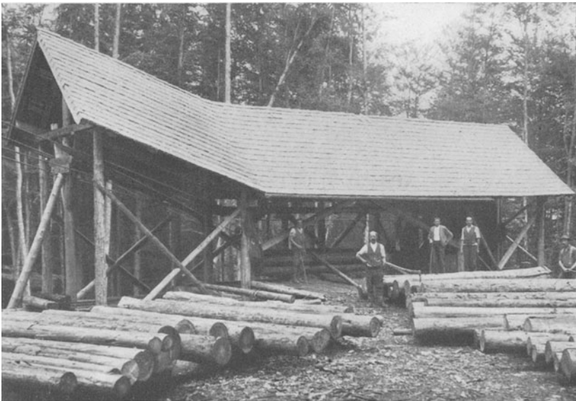
Abb. 25. Schöberlboden-Drahtseilriese; Beladestelle (Bundesforst Hintersee, Salzburg)
