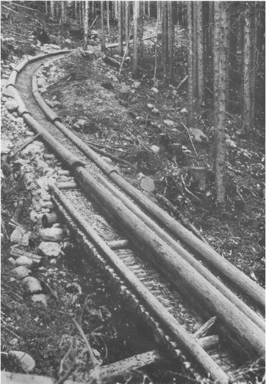
Abb. 22. Winterriesweg mit Bewehrung (Bundesforst Großreifling, Steiermark)
