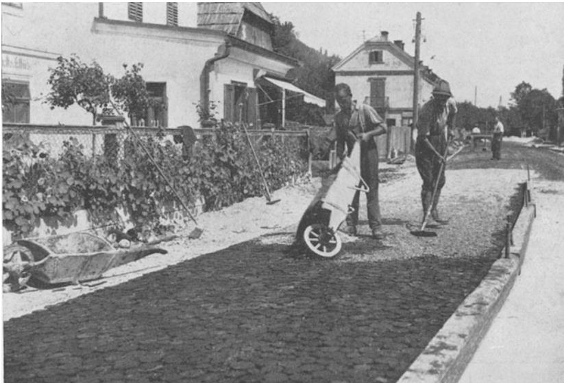
Abb. 75. Rundholzstöckelstraße in Mautern im Liesingtal (Steiermark); halbseitiger Einbau: Abdeckung mit Steinsplitt
