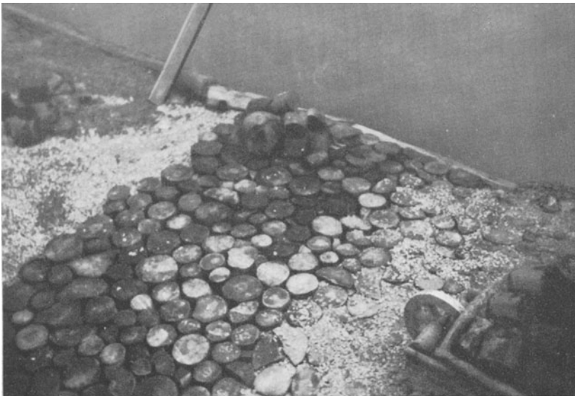
Abb. 73. Straßenbau-Versuchsstrecke (Dombachstraße im Wienerwald) mit Holzsteindecke vor der Einbringung von Split
