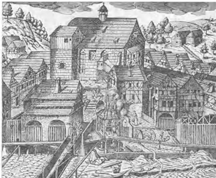
Abb. 254. Der Karlsbader Sprudel um das Jahr 1600. Das Bild zeigt die Lochsteinfassungen. Im Vordergrund liegen ein Lochstein und eine hölzerne Steiglutte.
