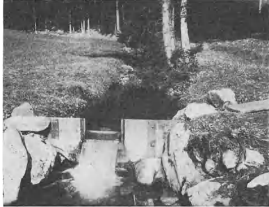
Abb. 22. Quellmessung mittels Überfall. (Aufnahme von Huber.)
