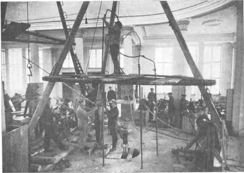
Abb. 258. Versteinerungsverfahren von Dr. Joosten. Durchführung der Versteinerung unter der neuen Quellenhalle in Franzensbad. (Ausgef. i. J. 1929 von der G. Rumpel A.-G.)
