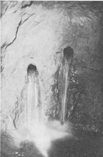
Abb. 146. Durch Bohrung erschlossene Quellen in der Molasse. (Nach H. C. Ryser, Bern.)
