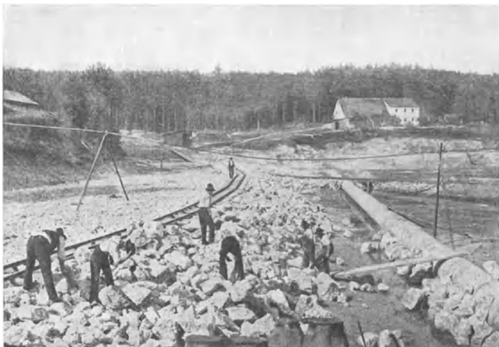
Abb. 128. Ausfüllung des Quellfassungsbeckens bei Ranna.
