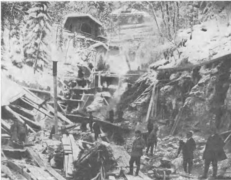
Abb. 251. Fassung der Reissacher-Quelle in Bad Gastein. Beispiel einer Quellaufschlußarbeit. (Ausgef. von der G. Rumpel A.-G.)
