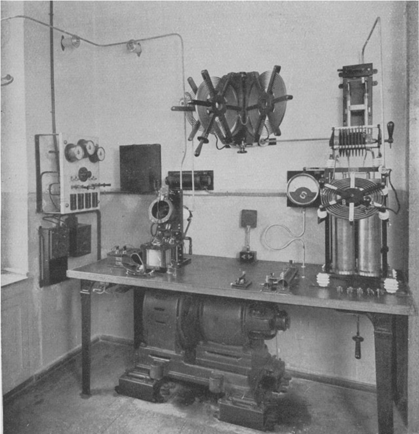
Abb. 295. Löschfunkensende- und -empfangsstelle; 1,5 Kilowatt Antennenleistung (Gesellschaft für drahtlose Telegraphie, Berlin).
