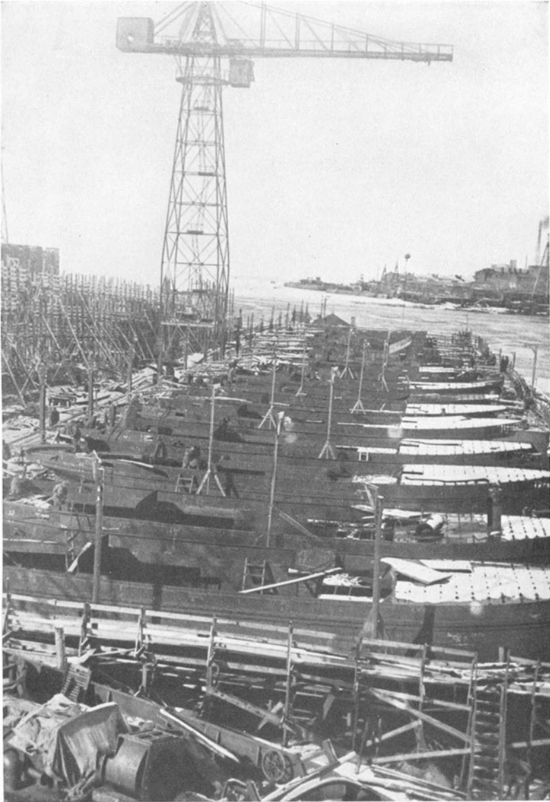
Abb. 69. Serienweiser Schiffbau in Leningrad. 1929
