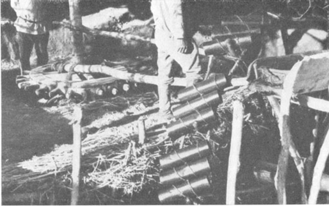
Abb. 9. Typisches Schöpfwerk am Unterlauf des Syrrdarja (1928).
