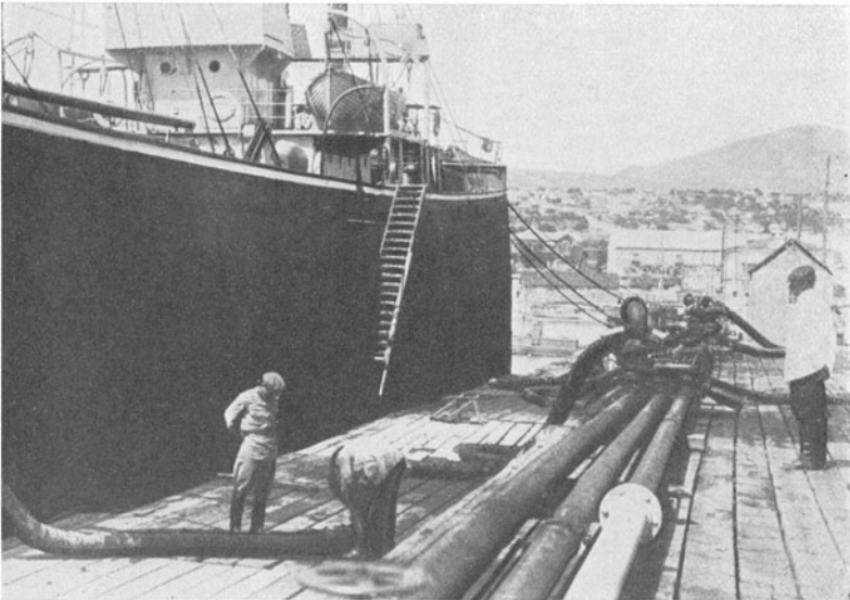
Abb. 3. Mittels Röhren wird das am Kaspisee gewonnene Petroleum am Schwarzen Meer in die Schiffsbäuche gedrückt. Rusfoto
