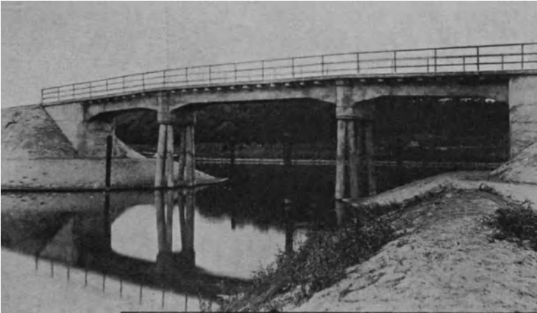
Fig. 63. Havelbrücke am Großschiffahrtswege Berlin-Stettin.
