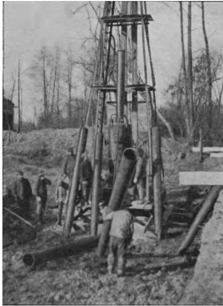
Fig. 24. Konische Betonpfähle „Mast“.
