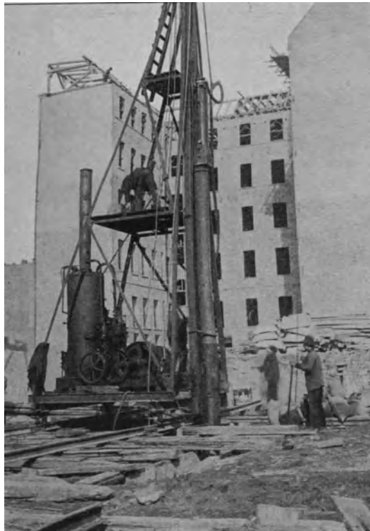
Fig. 17. Einrammen von Betonpfählen „Mast“ neben Neubauten.
