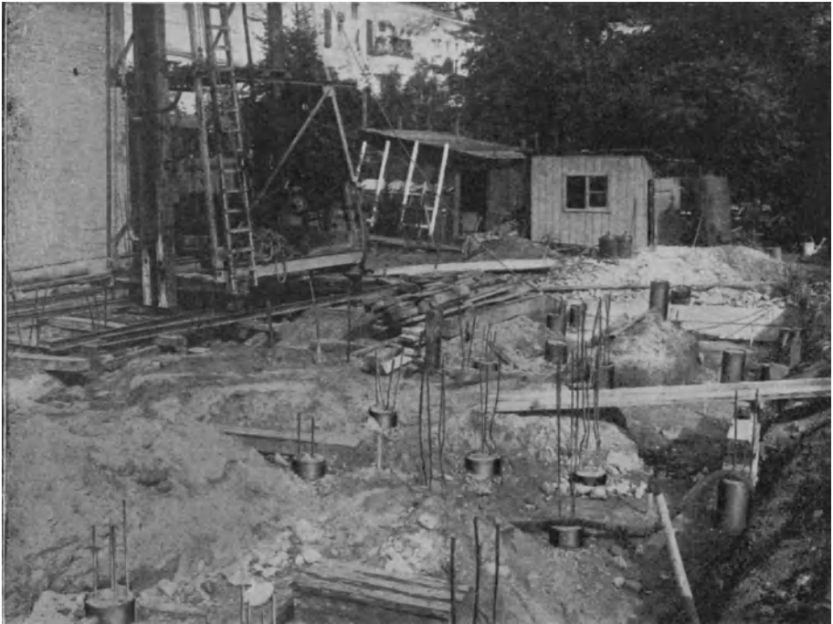
Fig. 31. Baustelle während der Rammarbeiten.
