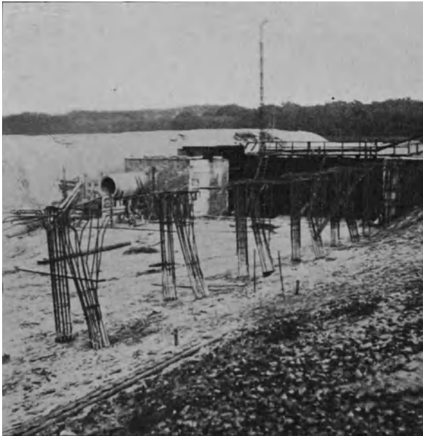
Fig. 60. Eisenarmierung des Leitwerkes. Im Hintergrunde die Schleuse.
