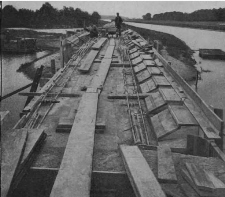
Fig. 66. Havelbrücke während der Ausführung.
