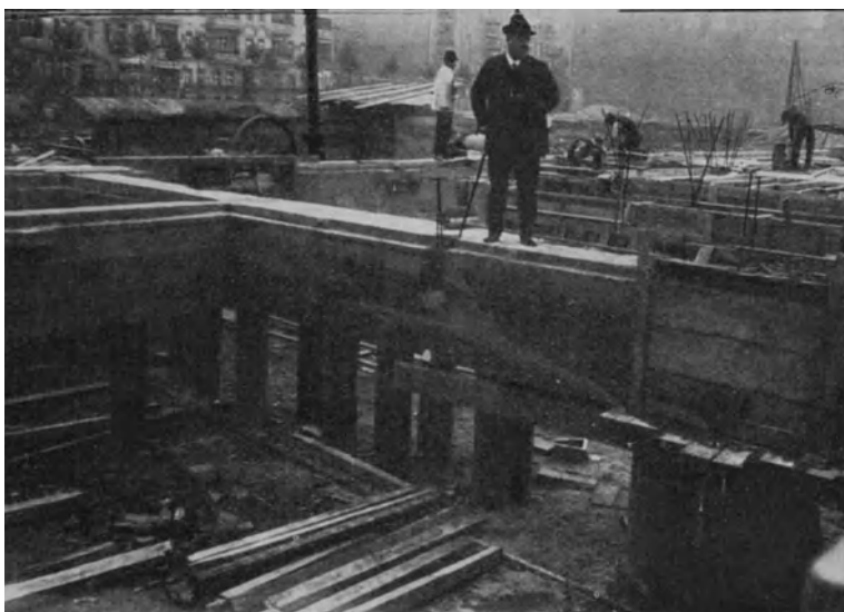
Fig. 44. Eisenbetonbalken und -decken auf Betonpfählen „Mast“ beim Kirchenbau Berlin-Neukölln.
