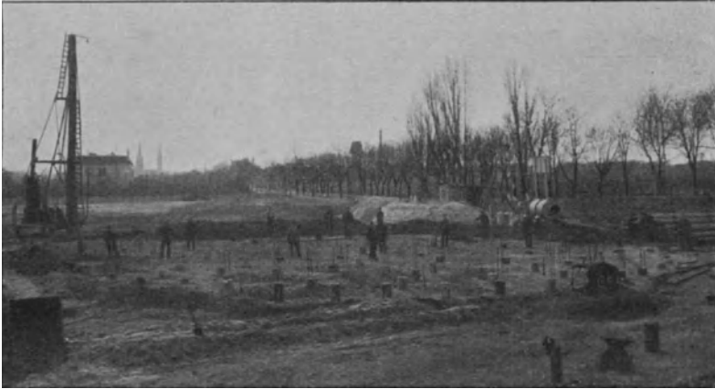
Fig. 69. Baustelle während der Rammarbeiten.
