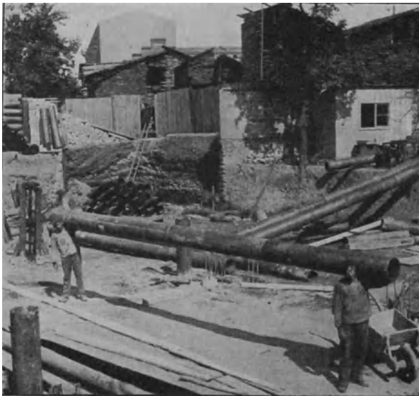
Fig. 10. Transport der 10 m langen Mast-Pfähle zur Ramme.
