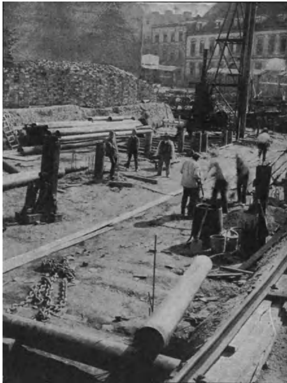
Fig. 13. Betonieren der Pfähle auf der Baustelle.
