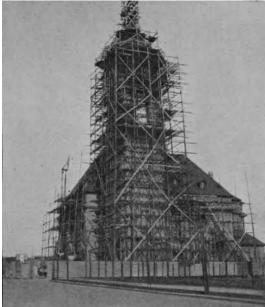
Fig. 40. Kirche in Berlin-Pankow während der Bauausführung.
