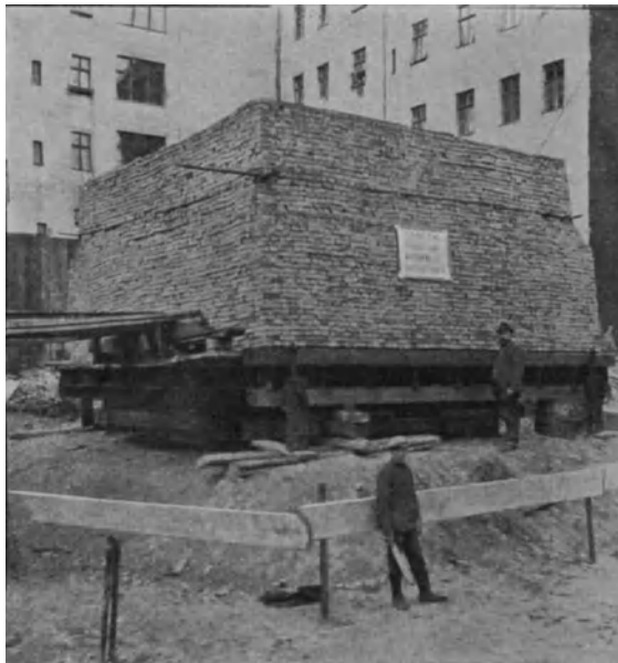
Fig. 48. Gemeinschaftsschule Zechlinerstraße. Belastung der Betonpfähle „Mast“ mit 284 000 kg.
