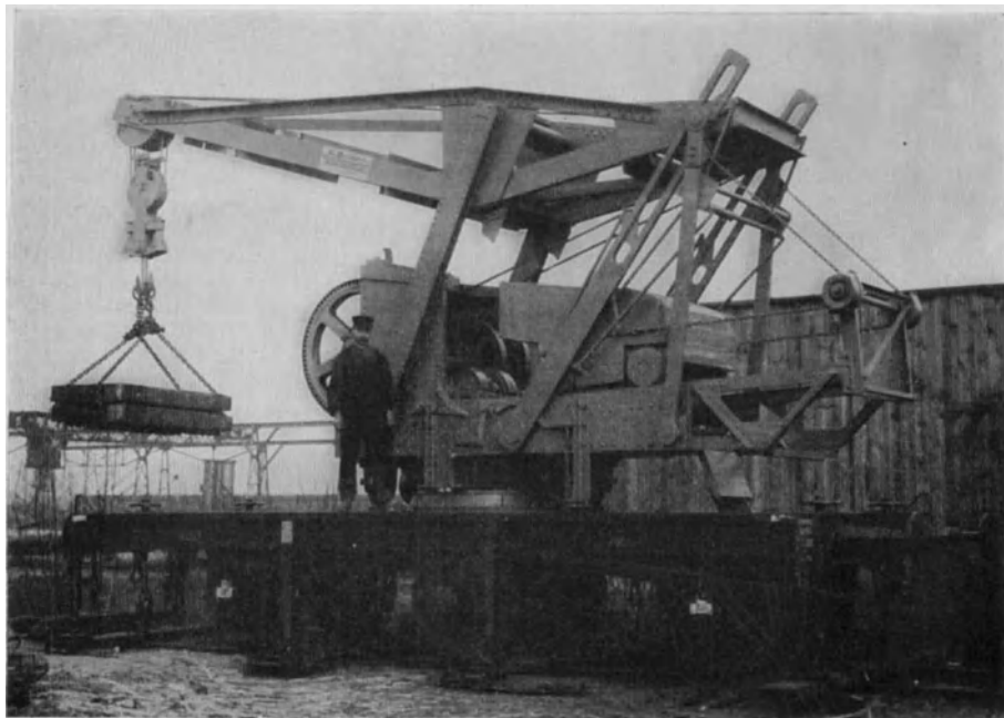
Abb. 408. Eisenbahnwagendrehkran von 10 t Tragfähigkeit für Handbetrieb (Becker).
