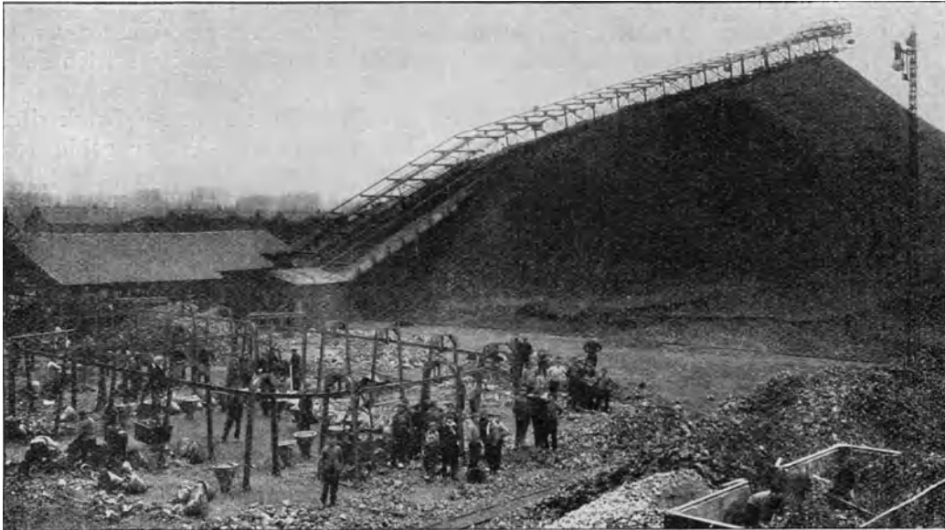
Abb. 105. Hängebahn mit Handbetrieb (im Hintergrunde eine Haldenhängebahn mit Seilbetrieb) (Pohlig).
