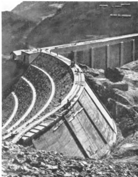
Abb. 276. Cignana-Steinfülldamm (Italien). Schaubild.
