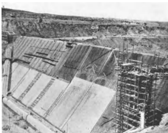
Abb. 297. Bakhada-Staudamm. Herstellung der Eisenbetondichtungsdecke.
