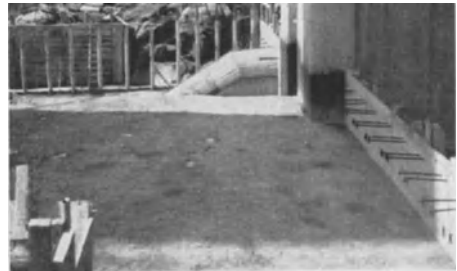
Abb. 1061. Bleiloch-Staumauer. Verankerung der Gleitschalung.
