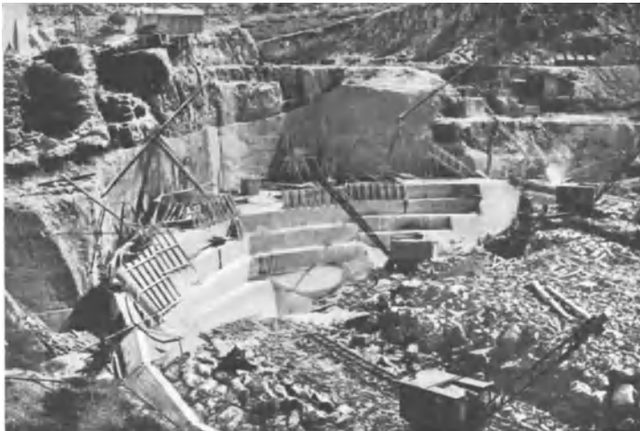
Abb. 156. Foum-el-Gueiss-Steindamm. Hangeinfeldmauer und torkretierte Schiefertonschlusflächen während der Herstellung.
