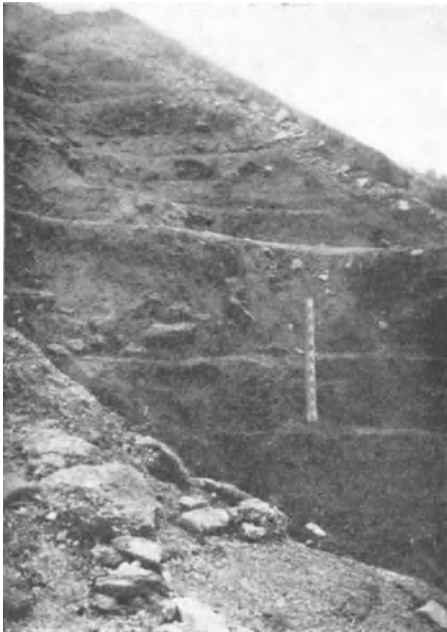
Abb. 308. Walzfugen in der wasserseitigen Dichtungsschicht (Weißes-Desse-Damm).
