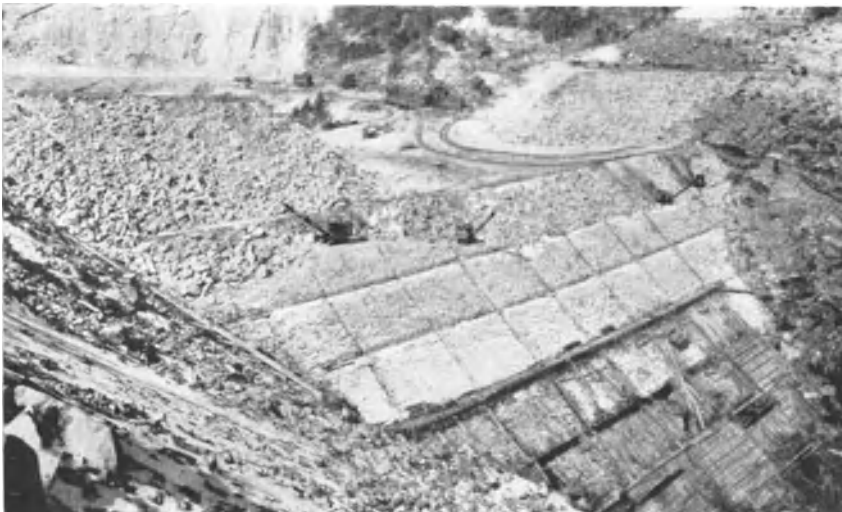
Abb. 285. Salt-Lake-Steindamm-USA. Fugenaufteilung der Dichtungsdecke.
