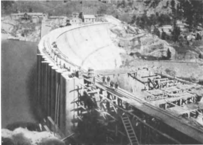
Abb. 566. Ansicht der Ceresole-Reale-Staumauer mit Lévy'schen Schutzgewölben.
