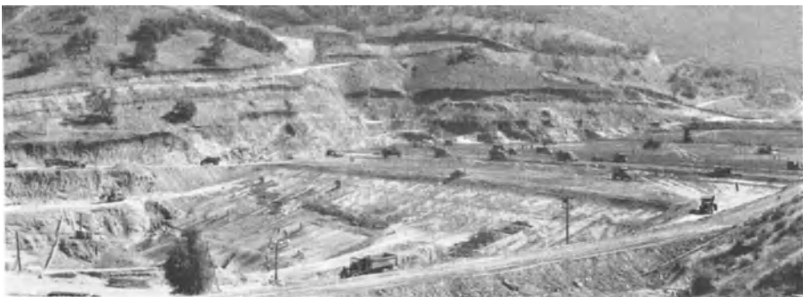
Abb. 338. Bouquet-Cañon-Damm Nr. 1. Größte Schütthöhe 67,5 m. Gewalzte Schüttung. (Lichtbild von Proctor, Los Angeles.)
