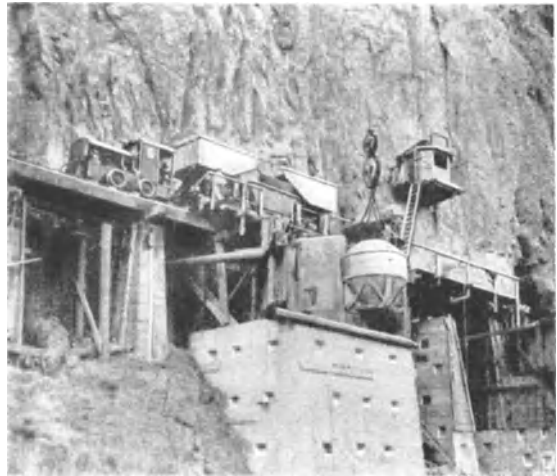
Abb. 1030. Owyhee-Staumauer. Heranbringen des fertigen Betons.
