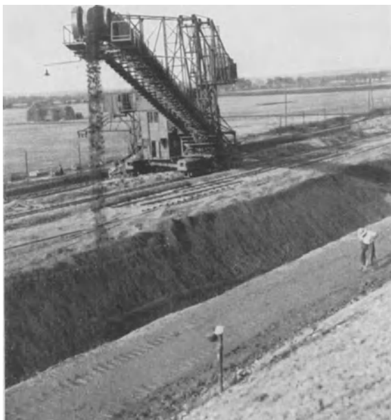
Abb. 336. Staudamm Ottmachau. Normale Schüttung.
