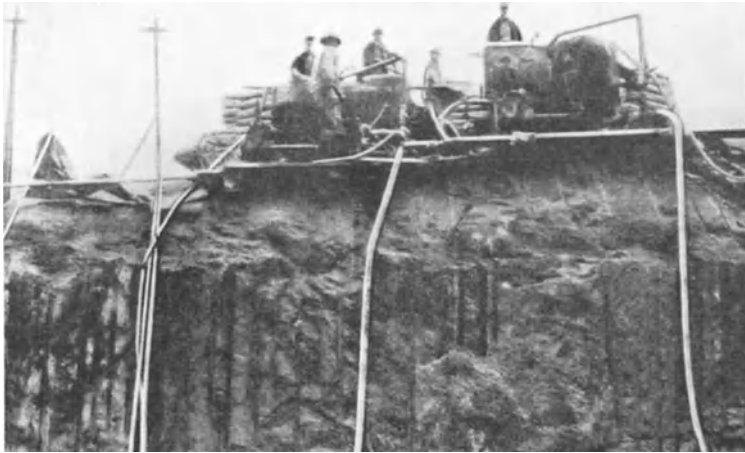
Abb. 264. Norris-Staumauer. Hochdruckeinpressung in Gruppen.
