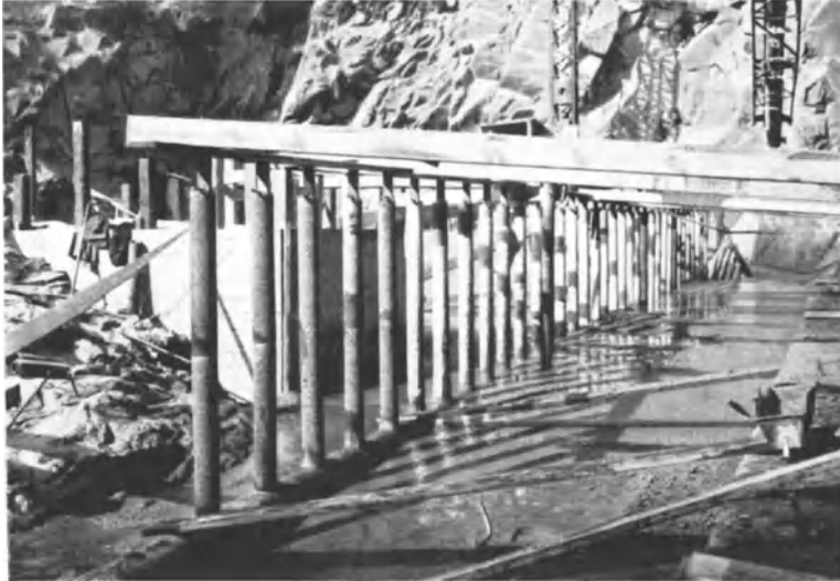
Abb. 552. Bleiloch-Sperre. Einbetonieren der Entwässerungsleitungen.
