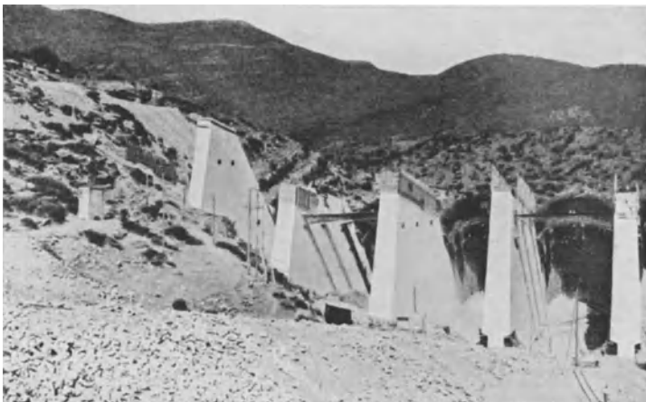
Abb. 900. Beni-Bahdel-Pfeilerstaumauer von Luftseite.
