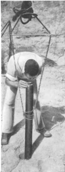
Abb. 189. Norris-Staumauer. Fernglas zur Besichtigung der Bohrbocher.
