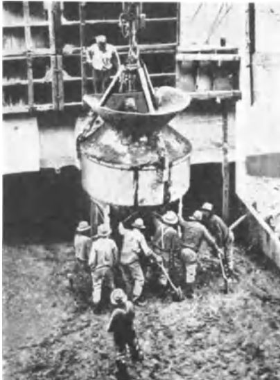
Abb. 1029. Owyhee-Staumauer. Entleeren des Kübels.
