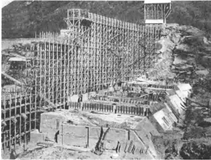
Abb. 1020. Betonierbrücke der Ceresole-Reale-Staumauer.
