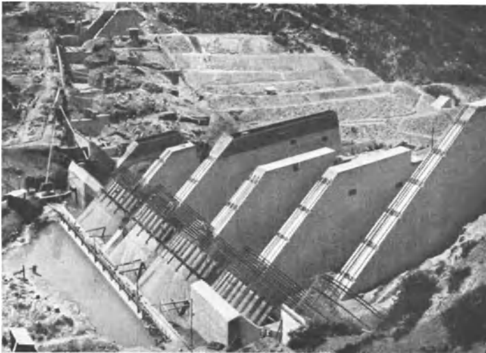
Abb. 254. Beni-Bahdel-Gewölbereihenstaumauer (Frankreich; 20 m Pfeilerabstand). Blick auf die Gründungsfläche des linken Hanges.
