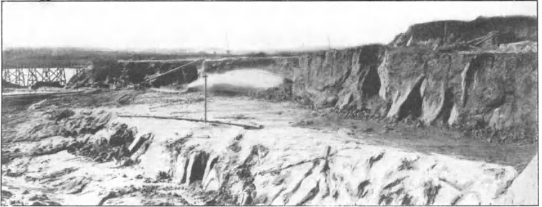
Abb. 360. Spülspritze am Necaxa-Damm.
