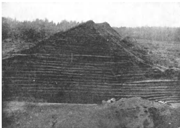
Abb. 307. Walzfugen, 6 Jahre nach Herstellung freigelegt (Weiße-Desse-Damm).
