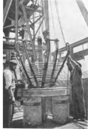
Abb. 750. Ankerkopfbewehrung.
