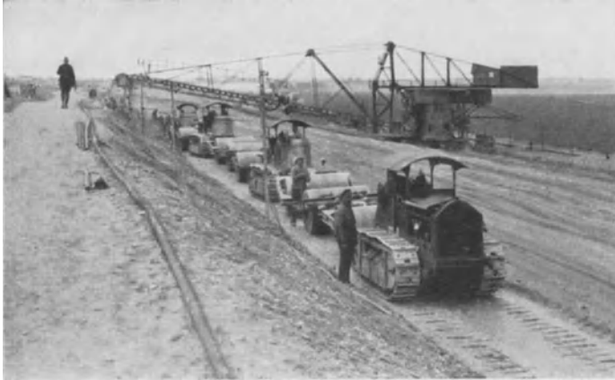
Abb. 339. Staudamm Ottmachau. Walzen des Tons.
