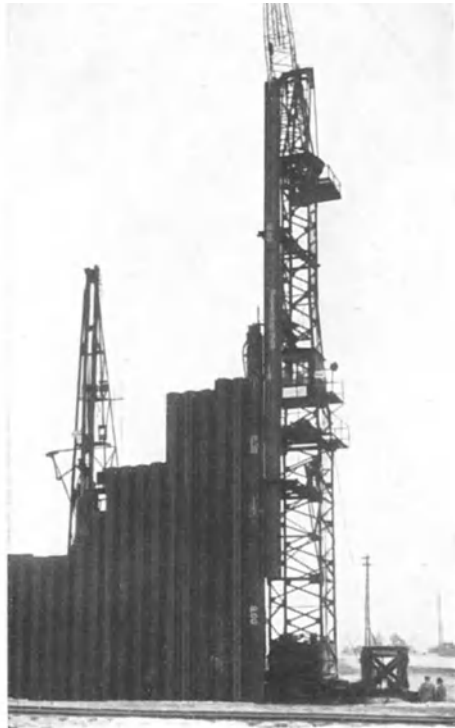
Abb. 238. Malapane-Staudamm. Einfädeln einer 24 m langen Spundbohle.
