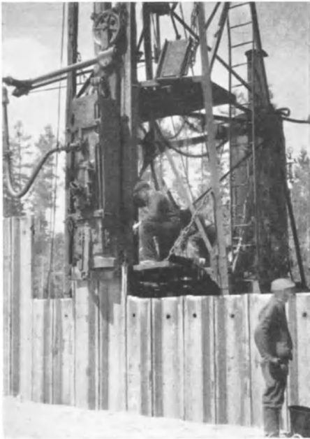
Abb. 237. Malapane-Staudamm. Rammern der Leichtspundwand mit Schnellschlaghammer.
