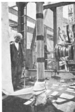
Abb. 746. Bündelung der Drähte.
