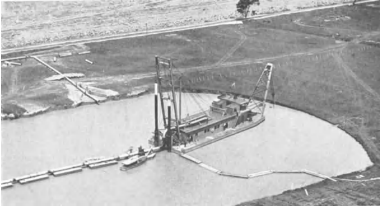
Abb. 362. Saug-Schwimmbagger (beim Aushub des Kanals der Wasserkraftanlage Beauharnois (nach Engng. News Rec.).
