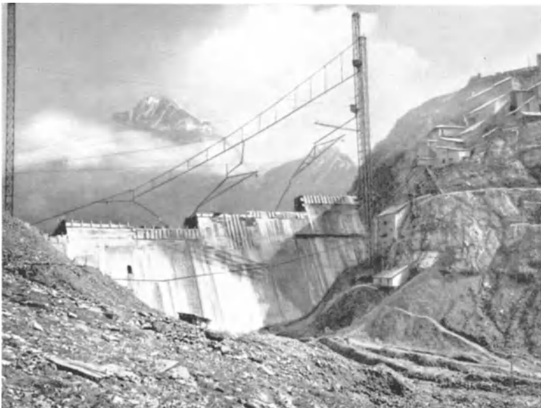
Abb. 1008. Barbellino-Staumauer (Italien) während der Herstellung.
