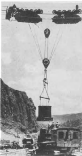
Abb. 1032. Boulder-Staumauer (USA.). Seillaufkatze. 150 t Tragfähigkeit.
