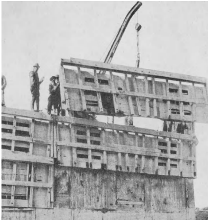
Abb. 1069. Norris-Staumauer. Umsetzen der Schalung mit Autokran.
