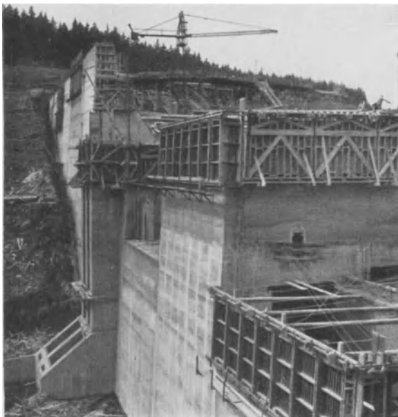
Abb. 1062. Zillierbach-Staumauer. Stahlgleitschalung.
