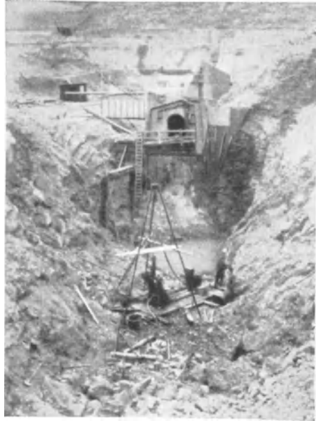
Abb. 261. Bever-Staudamm. Hochdruckeinpressung.
