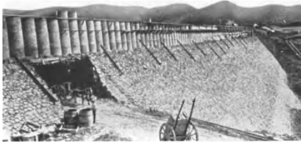
Abb. 295. L'Oued-Kebir-Steindamm (Tunis). Hohlkern und luftseitige Verpackung.
