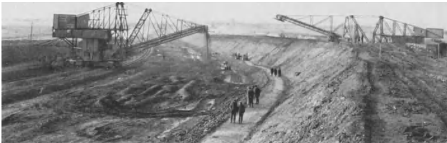
Abb. 334. Staudamm Ottmachau. Herstellung.
