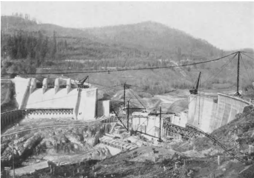
Abb. 1036. Derrick- und Drehkrane beim Bau der Ariel-Bogenstaumauer (USA).
