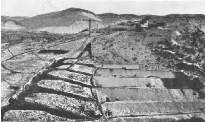
Abb. 253. Beni-Bahdel-Gewölbereihenstaumauer (Frankreich; 20 m Pfeilerabstand). Schlitzartige Gründung der Pfeiler.
