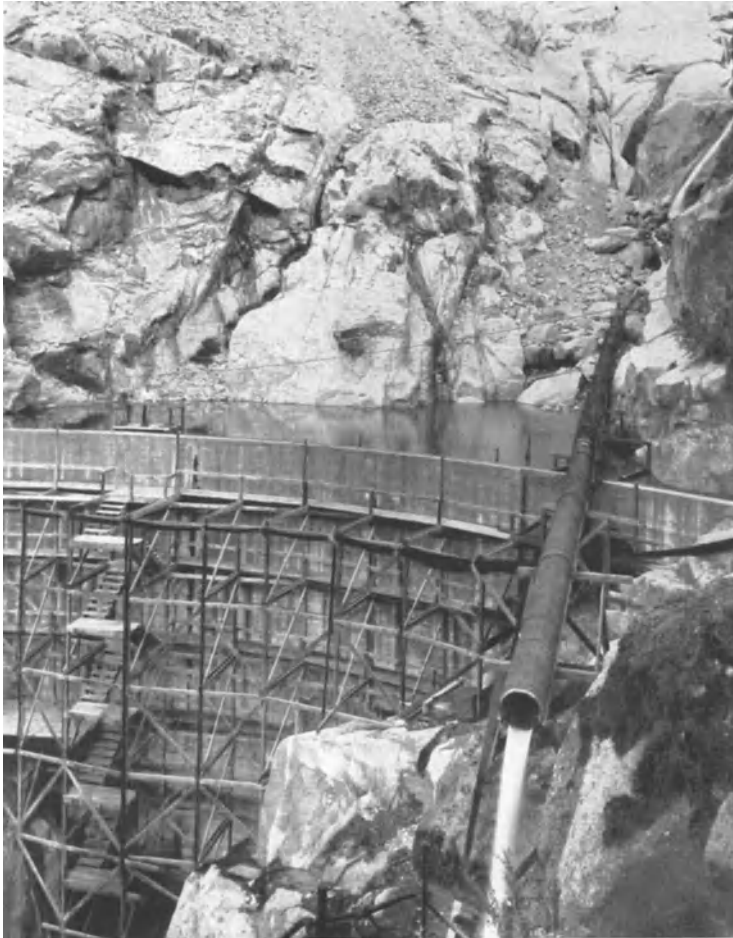
Abb. 803. Stevenson-Creek-Versuchsbogenstaumauer.
