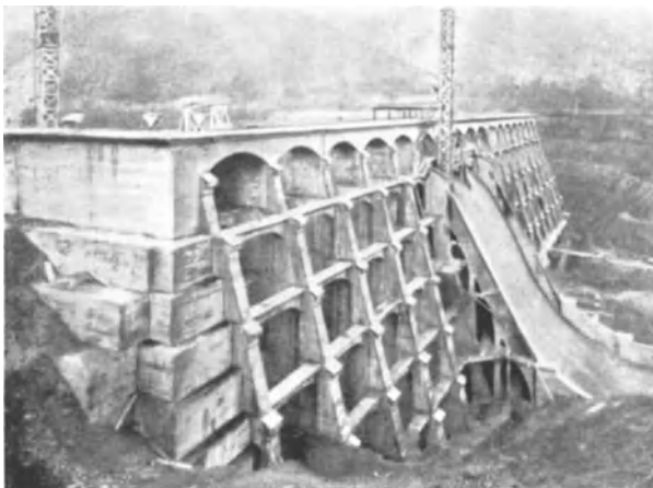
Abb. 882. Molato-Staumauer (Italien). Ansicht von Luftseite.
