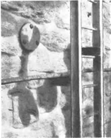
Abb. 1135. Setzclinometer, an Steilwand eingebaut.
