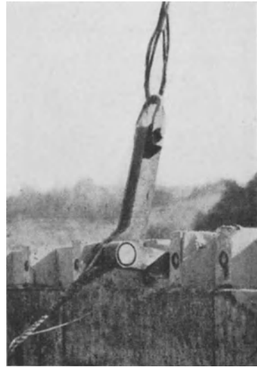
Abb. 1068. Norris-Staumauer. Schnabelhaken des Autokrans hebt die Schalungstafel aus der Führung.
