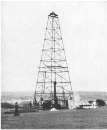
Abb. 181. 24 m hoher versetzbarer Bohrturm für Tiefbohrung. (Rio Negro, Uruguay. Ludin.)
