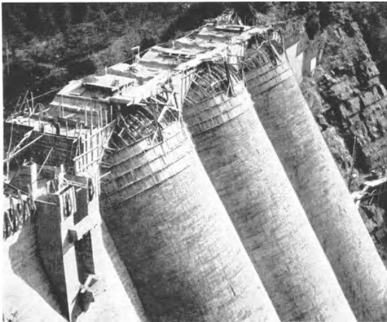
Abb. 890. Pavana-Staumauer. Herstellung der kalottenförmigen Gewölbeabschlüsse.
