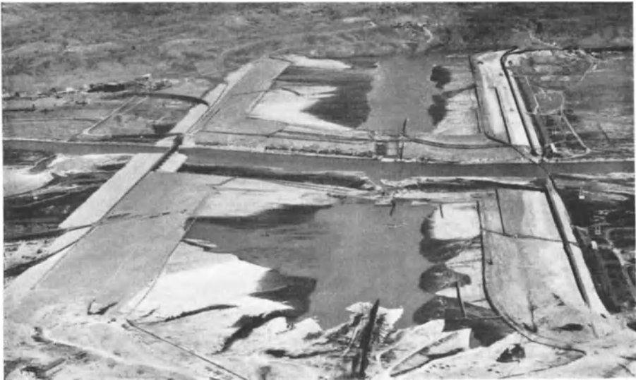
Abb. 359. Fort Peck-Staudamm-USA. (vollgespült), während der Herstellung 1 .
