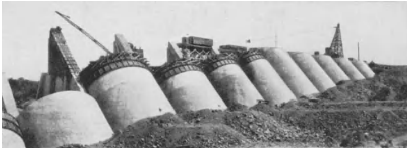
Abb. 898. Beni-Bahdel-Gewölbereihenstaumauer (Marokko). 20 m Pfeilerabstand.
