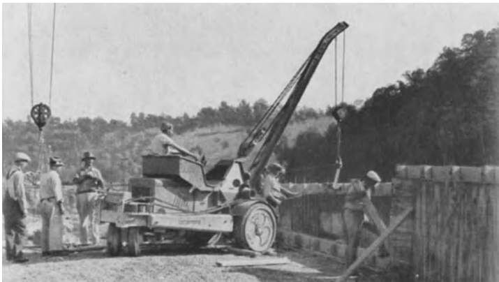
Abb. 1067. Autokrane der Norris-Staumauer zum Abheben und Umwechseln der Schalung.
