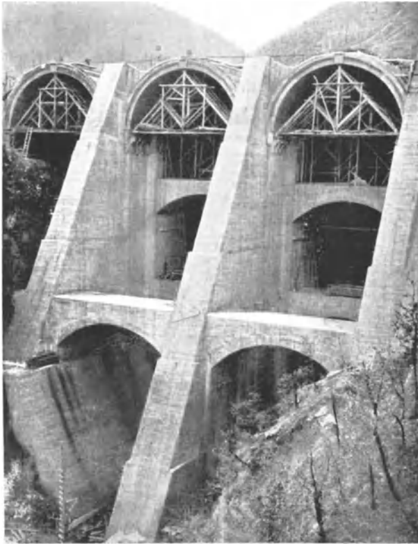
Abb. 891. Pavana-Staumauer von Luftseite.
