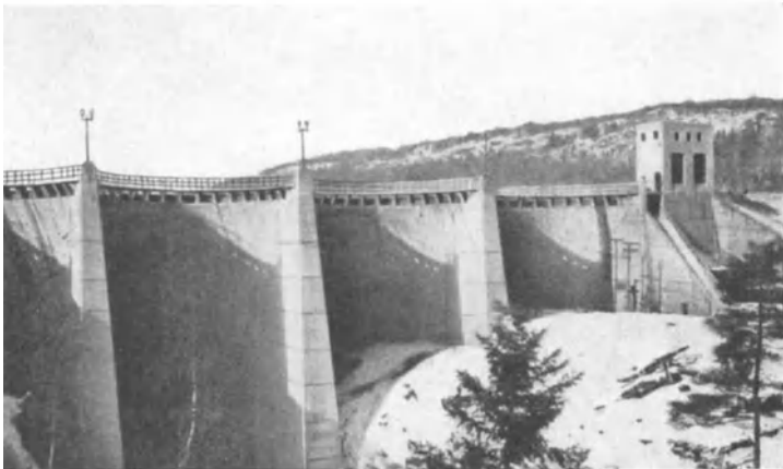
Abb. 7b. Viktoria-Gewölbereihen-Staumauer. Ansicht von Luftseite.
