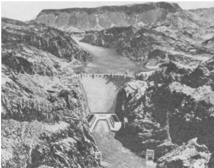
Abb. 2. Boulder-Staumauer mit Kraftwerk.
