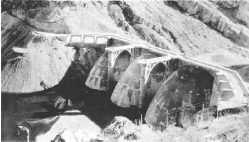
Abb. 909. Coolidge-Kuppelreihenstaumauer (USA.) nach Noetzi.
