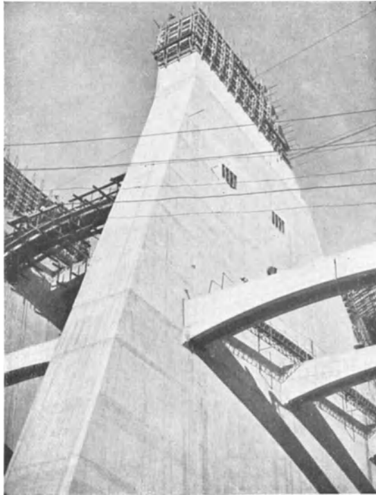
Abb. 1056. Beni-Bahdel-Pfeilerstaumauer (Marokko). Pfeilerherstellung nach dem Gleitschalverfahren.
