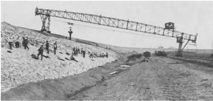
Abb. 340. Staudamm Ottmachau. Herstellung der Steinbestürzung.
