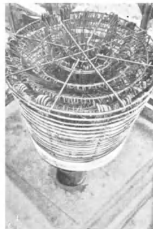
Abb. 748. Verbindung der Drähte mit dem Ankerkopf.
