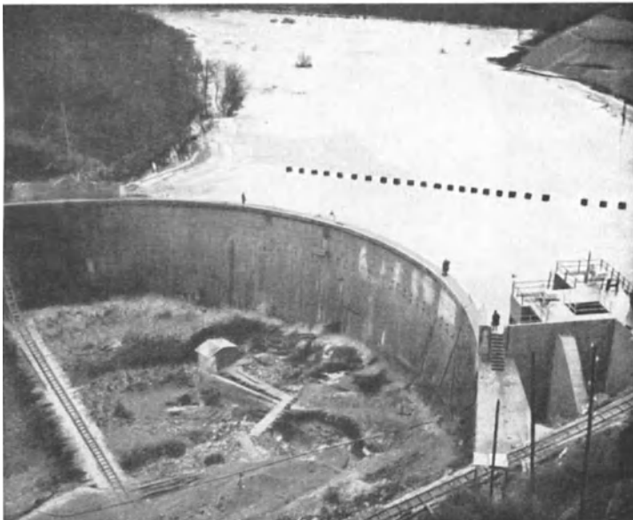
Abb. 782. St. Etienne-Cantales-Bogenstaumauer (Frankreich).
