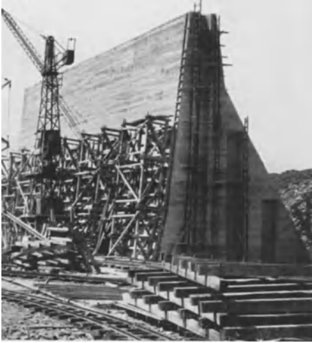
Abb. 1057. Herdecke-Staumauer. Herstellung nach dem Gerüstschalverfahren.
