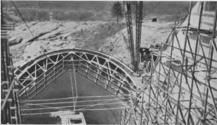
Abb. 1066. Viktoria-Pfeilerstaumauer. Dreigelenkbogen-Stahl-Gleitschalung für die Innenlaibung der Gewölbe.
