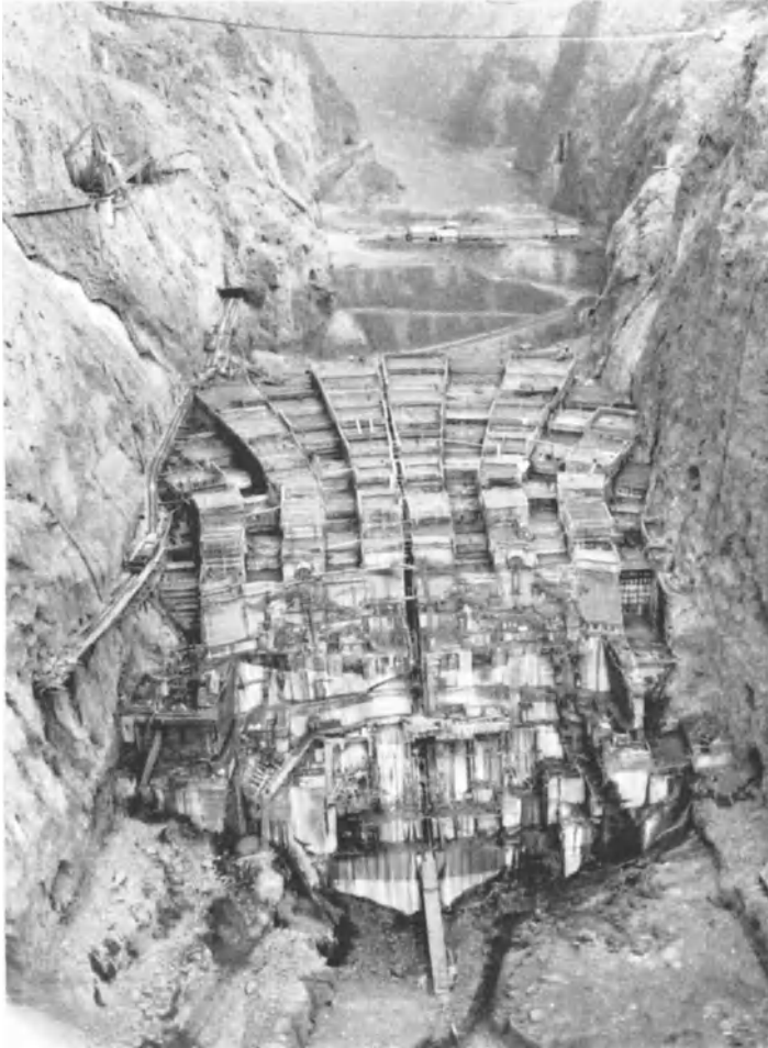
Abb. 517. Boulder-Staumauer-USA. Blockaufteilung und Kühlpalt in Mauermitte.
