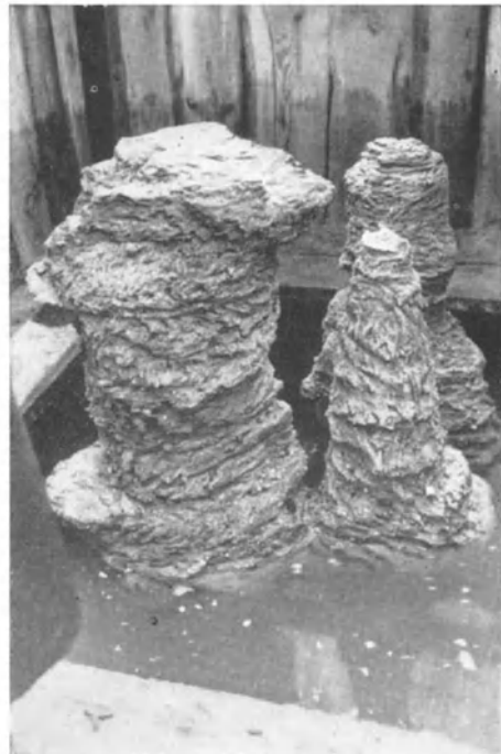
Abb. 240. Malapane-Staudamm. Chemisch verfestigter Sand, Spritzrohrabstand 1 m.
