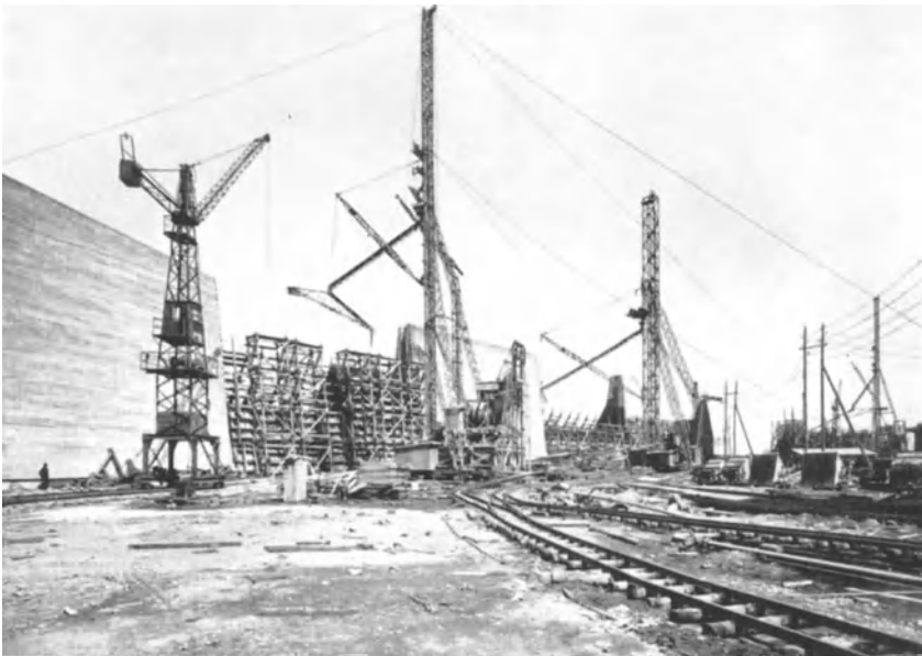
Abb. 1004. Fahrbare Gießtürme beim Bau der Herdecke-Staumauer.
