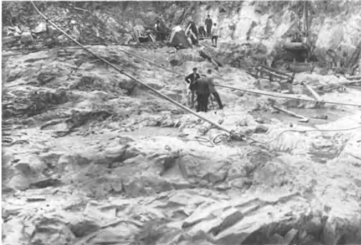
Abb. 252. Bleiloch-Staumauer. Reinigen der Gründungsfläche mit Druckwasser.
