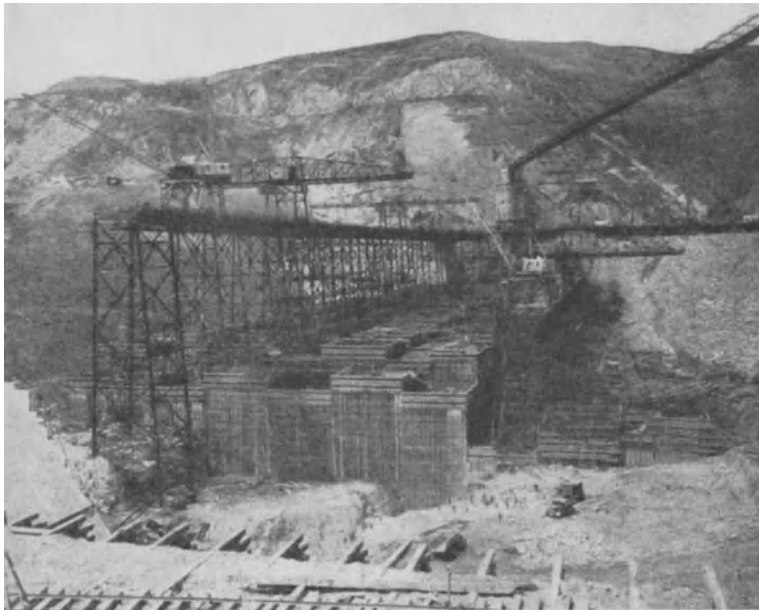
Abb. 1039. Drehkrane und Brückenkrane mit Kübelkatzen beim Bau der Grand Coulee-Staumauer (USA).
