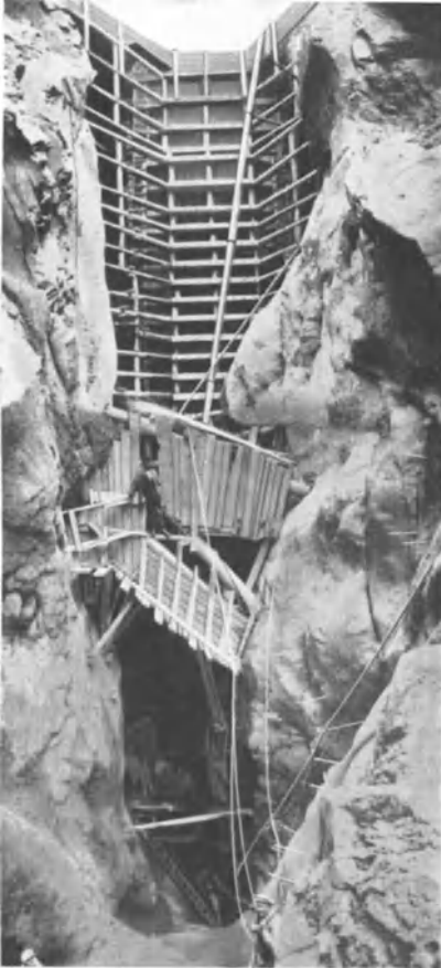
Abb. 141. Chambon-Staumauer. Aushub der Erosionsrinne und Versteifung der Baugrube.
