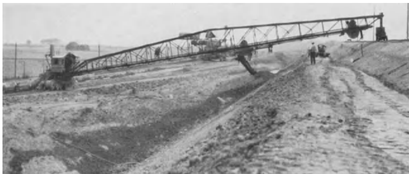
Abb. 335. Staudamm Ottmachau. Toneinbringung.
