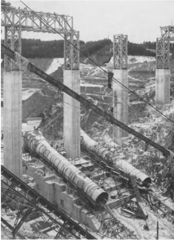
Abb. 1007. Bleiloch-Staumauer. Aufhängung der Kabelrinnen.
