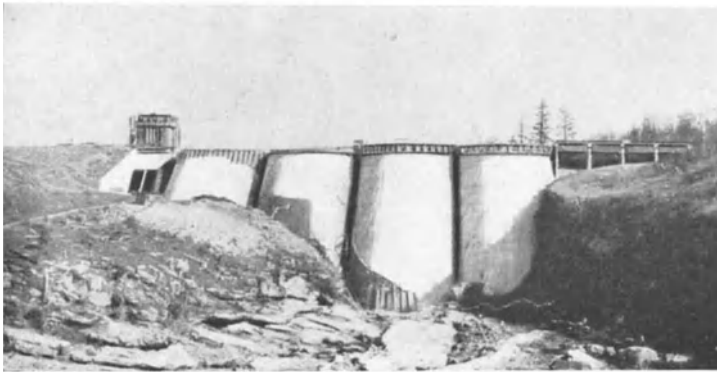
Abb. 7a. Viktoria-Gewölbereihen-Staumauer. Ansicht von Wasserseite.
