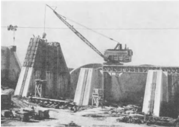
Abb. 1037. Herstellung der Pfeiler der Hamilton-Staumauer.
