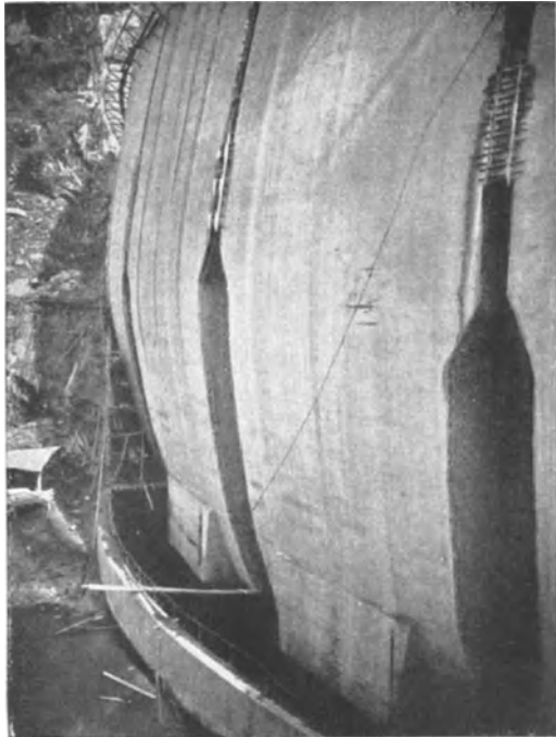
Abb. 810. Fugenkühlspalte mit Ausweitung zur Hochwasserabführung.
