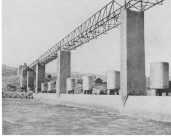
Abb. 752. Cheurfas-Staumauer nach der Verstärkung.
