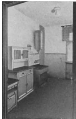
Abb. 72. Heißwasserspeicher in einer elektrischen Küche.
