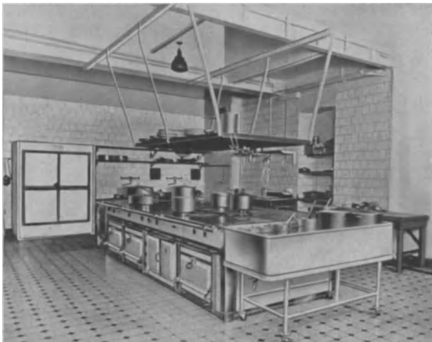
Abb. 146. Richtige Aufstellung eines Großküchenherdes. (Vorn ein Bain-Marie.)
