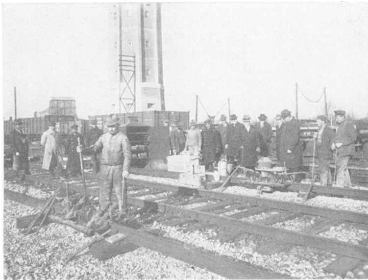
Abb. 96. Schienenschweißung.
