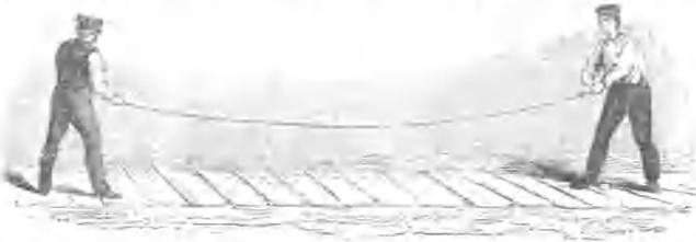
Fig. 272. Herstellung der Glasröhren.
