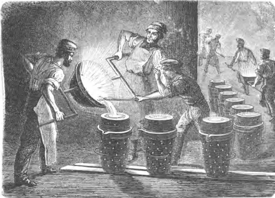
Fig. 59. Guß von 100pfündigen Langgeschossen im Arsenal von Woolwich.
