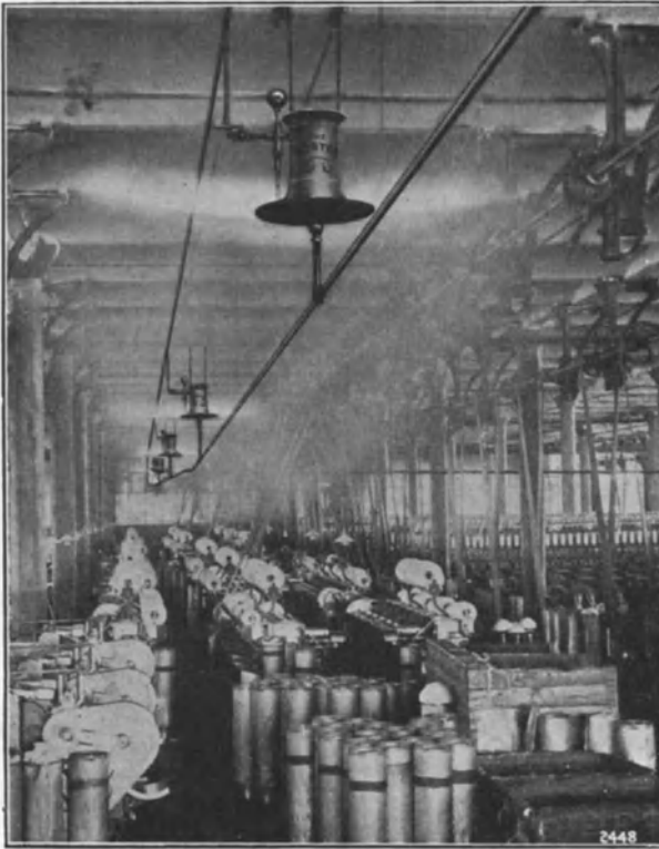
Abb. 53a. Einzelbefechter mit Druckwasserdüse (Vortexapparat von Mather & Platt, Manchester).
