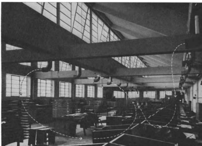
Abb. 37. Arbeitsraum einer Zigarrenfabrik mit zwei Zuluftströmen verschiedener Temperatur (Entwurf und Ausführung: Dipl.-Ing. M. Hirsch, Frankfurt a. M.).
