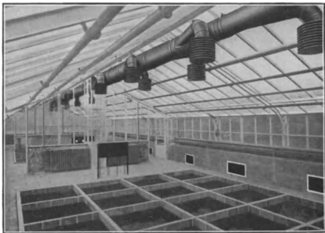
Abb. 84. Zugfreie Luftverteilung in einem Treibhause (Berventulo G. m. b. H., Berlin).
