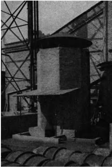
Abb. 30. Rohölreinigungsöfen einer Dieselmotorenzentrale von über 1000 PS.
