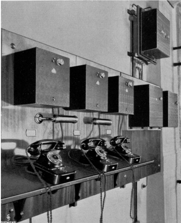
Abb. 116. Anordnung mehrerer Wahruf-Fernsprecher und Kupplungsübertragungen in einer Dienststelle.
