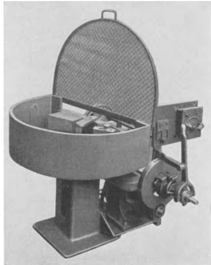
Abb. 68. Kaltbiegemaschine von Olsen.
