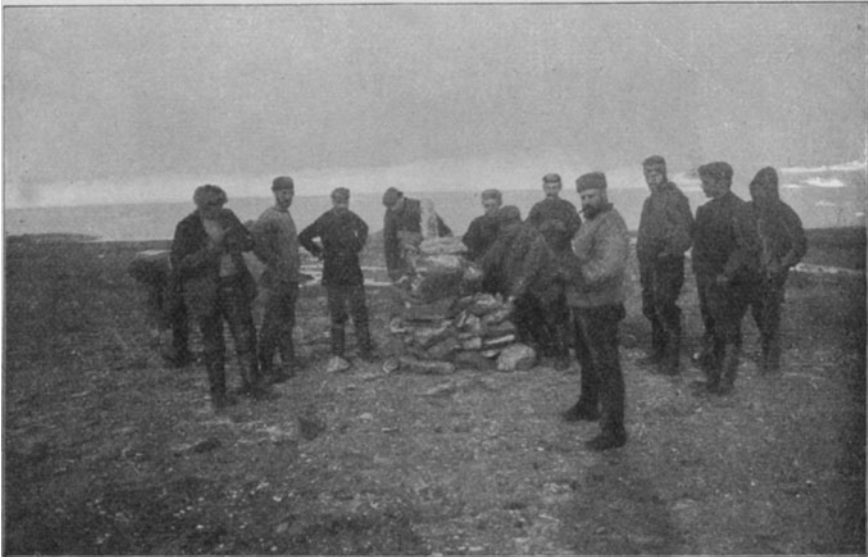
Bau der ersten Warte am Strande der Großen Koldewey-Insel.
