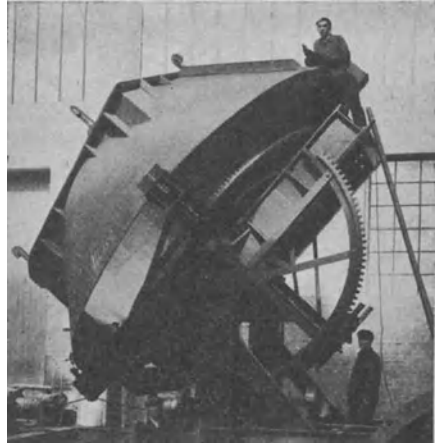
Abb. 202. Schweißung eines Einfüllstutzens in Schwenkvorrichtung.
