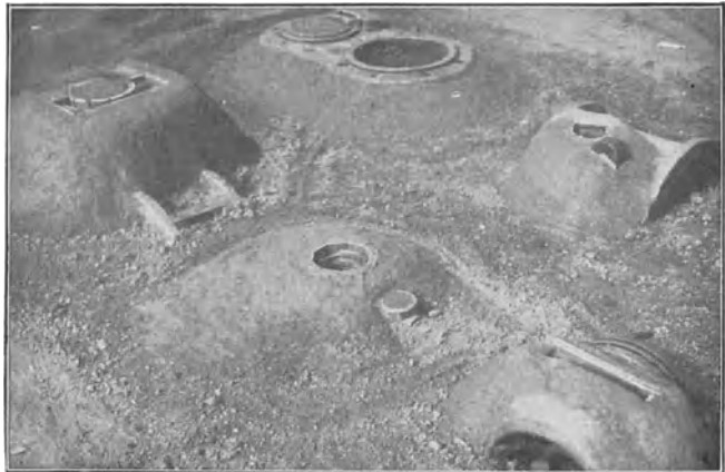
Abb. 321. Zur Warmschweißung vorbereitete Gußstücke.
