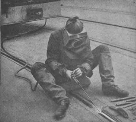
Abb. 147. Schweißer mit Schweißgerät (beim Schienen-aufschweißen).
