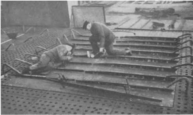
Abb. 284. Schweißen eines Schotts auf der Spannplatte.
