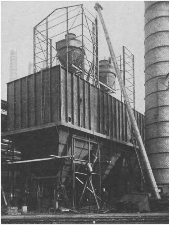
Abb. 220. Geschweißter Großraum-Kohlenstaubbunker.
