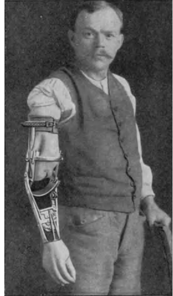
Abb. 19. „Bizepsprothese“. Durch die Unterfütterung des Bizeps (vgl. die Bilder desselben Falles 16a und b) wird mittels Umschaltung sowohl die Ellbogenbeugung wie der Fingerschluß ausgeführt.
