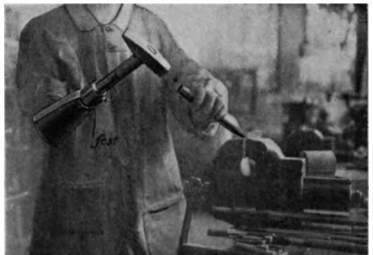
Abb. 34. Schräger Schlag (Schroten).
