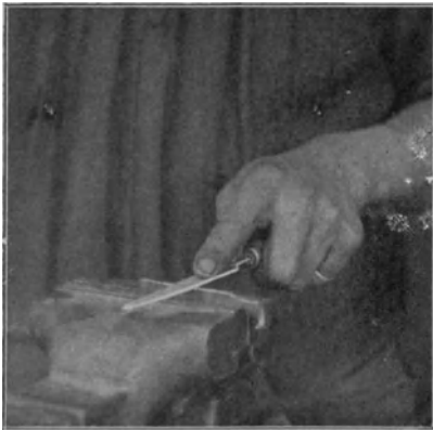
Abb. 17 und 18. Oberarmamputierter einhändig feilend. Mit kleiner Rundfeile kann sich der Oberarmamputierte einhändig nur vorübergehend aushelfen. Jeder Wettbewerb mit dem Gesunden ist ausgeschlossen.
