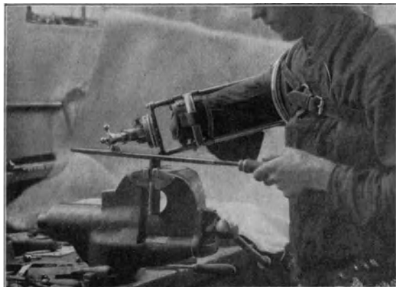
Abb. 12. Führung der Feilenspitze mit Kunstarm (Ansatzstück wird lediglich auf die Feile gedrückt).
