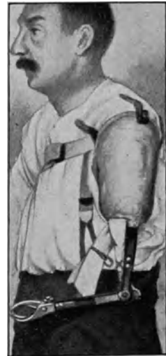
Abb. 13. Biesalskis Gipsleim-Prothese mit offener Stumpfhülse zur Ermöglichung der Haut-Extension.
