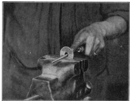
Abb. 17 und 18. Oberarmamputierter einhändig feilend. Mit kleiner Rundfeile kann sich der Oberarmamputierte einhändig nur vorübergehend aushelfen. Jeder Wettbewerb mit dem Gesunden ist ausgeschlossen.
