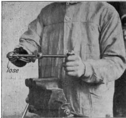
Abb. 40 und 41. Arbeiten mit dem Windeisen. Handgelenk lose.
