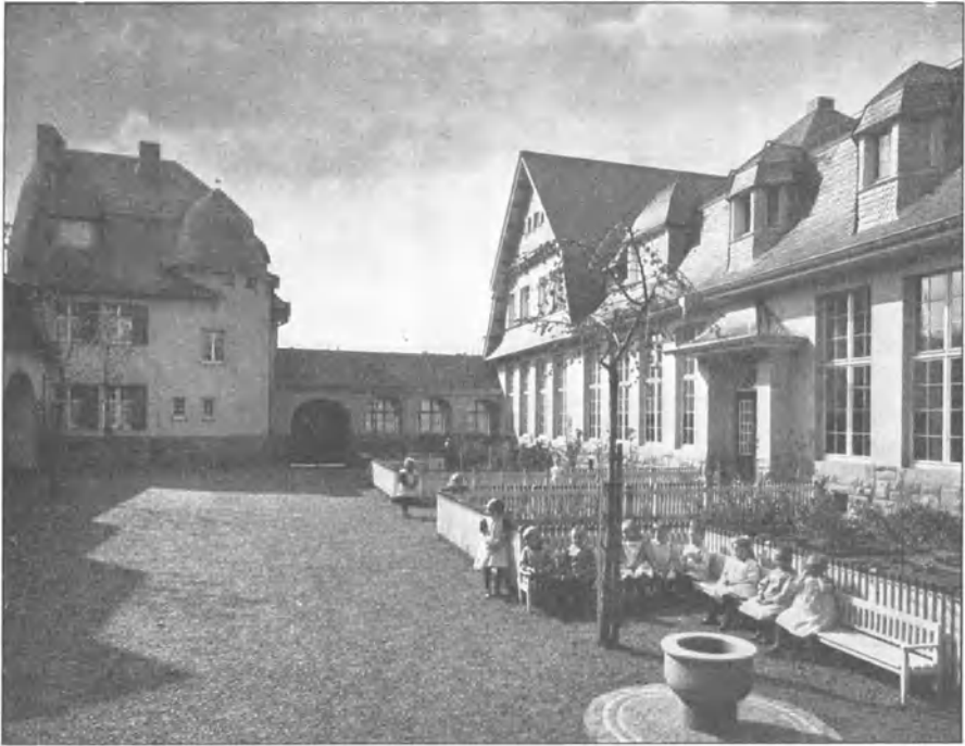
Fig. 52. Kindergarten in der Deliusstraße zu Aachen. Spielhof.
