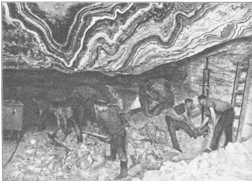
Abb. 53. Durch Druck stark gefaltetes Kalisalzager. Die losgesprengten Salzmassen werden laderecht zerschlagen. Neue Sprenglöcher werden vorbereitet. (Deut. Kali-Syndikat, Berlin.)
