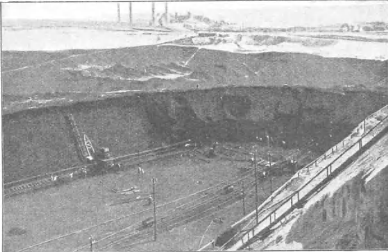
Abb. 76. Braunkohlengrube Elise II bei Leuna. (Aus dem Werk „Die Badische Anilin- und Sodafabrik Ludwigshafen a. Rhein“.)
