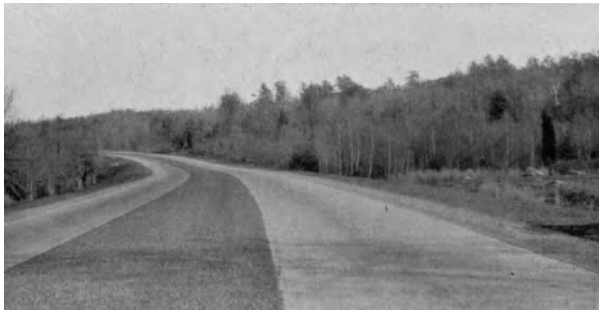
Abb. 46. Fordstraße, 30 Zoll breit, in der Mitte alte Fahrbahn, bi- tumentungebundener Makadamstreifen, an den Außenseiten 2 Betonstreifen angebaut.
