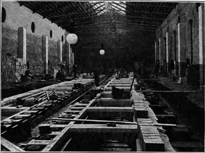
Meiserscher „Stiftofen“ im Bau.
