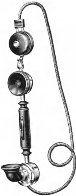
Abb. 1. Emgephon mit Steckkontakt und Anrufknopf.
