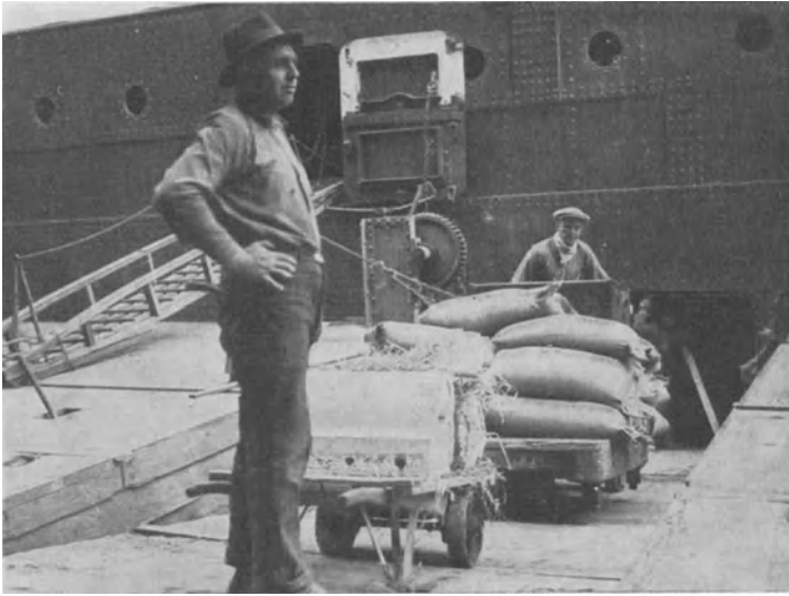
Abb. 5. Versenkbare Zugbrücke für Seitenportenbearbeitung in San Francisco.
