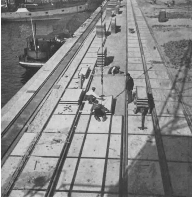
Abb. 34. Verlegung von Stelcon-Panzerbetonplatten.
