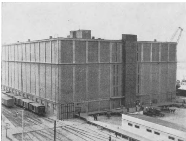
Abb. 73. Hafenkühlhaus in einem Ostseehafen.
