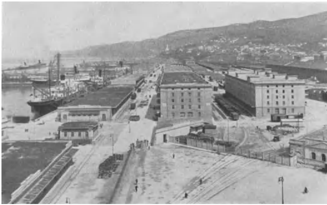
Abb. 66. Freihafen Vittorio Emanuele III. in Triest, Umschlagschuppen und Lagerspeicher.
