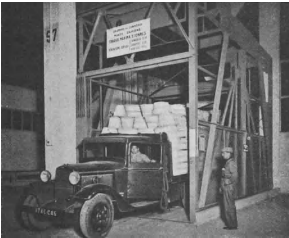
Abb. 35. Lastwagenaufzug von 8 t Tragfähigkeit im Joliettebecken in Marseille.
