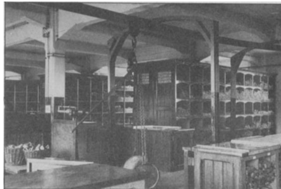
Fig. 102. Erdgeschoß mit Schwebekran.
