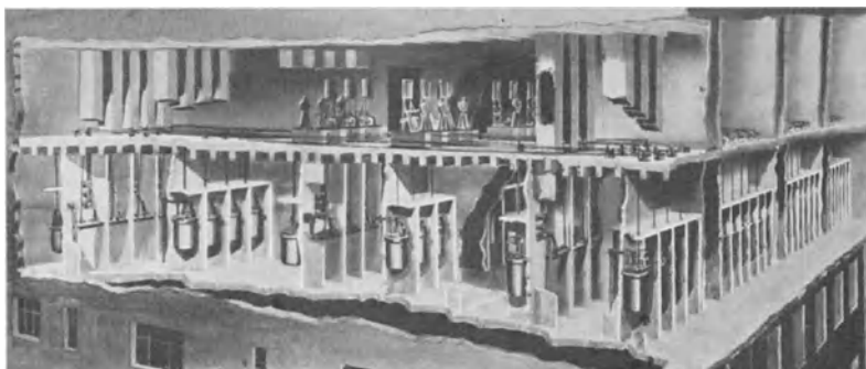
Abb. 99/10. Schaltanlage nach dem Grundsatz der vollständigen Phasentrennung. 15000 V Schalter für 1500000 kVA Leistung. (Westinghouse).
