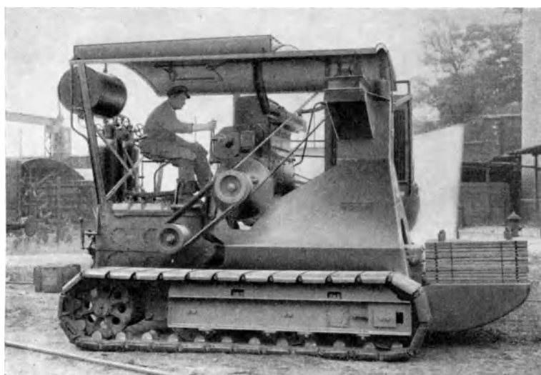
Abb. 26. Der große Bodenschwingungsrüttler des Losenhausenwerkes.
