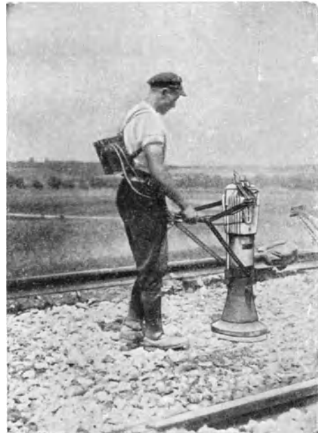
Abb. 24. Der Delmag-100 kg-Stampfer beim Stampfen einer Gleisbettung. (Delmag, Eßlingen.)
