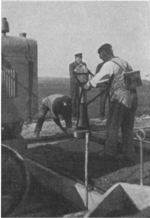
Abb. 41. Der Delmag-Betonstampfer (65 kg) im Augenblick des Hochspringsens. (Delmag, Eßlingen.)
