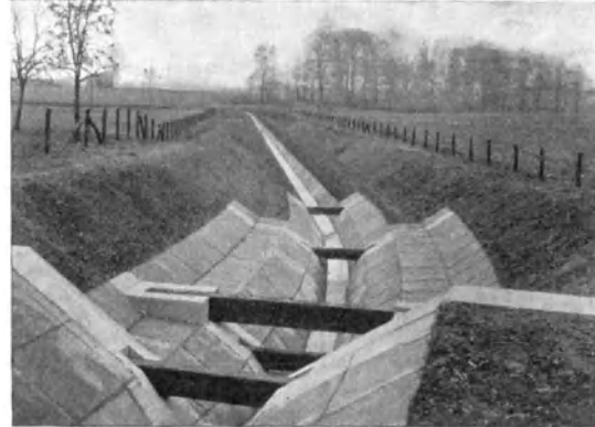
Abb. 182. Wasserbremse von A. Romshorn.
