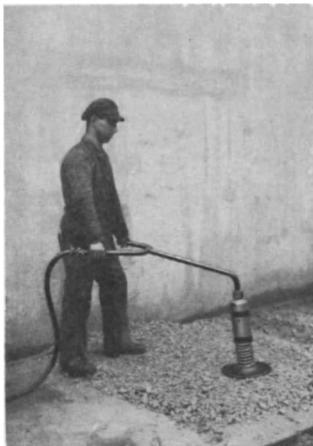
Abb. 40. „Deprag“-Betonrüttelstampfer.
