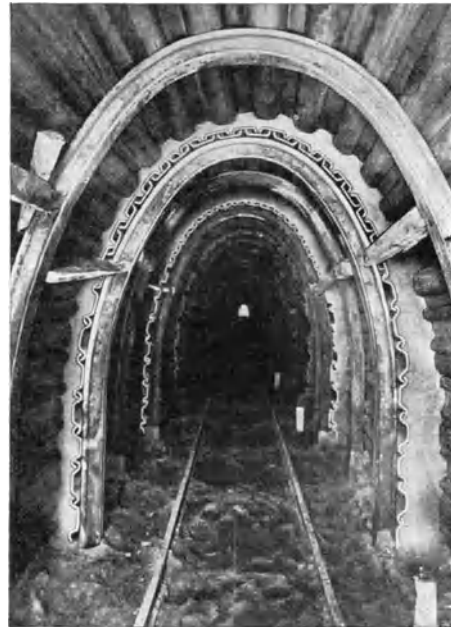
Abb. 22. Stollenvortrieb mit Union-Stollendiehlen. (Dortmund-Hoerder Stahlverein, Dortmund.)
