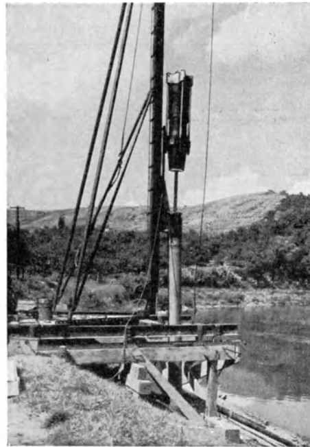
Abb. 55. Die 1/2-t-Delmag-Ramme mit Dreibein-Rammgerüst. (Delmag, Eßlingen.)
