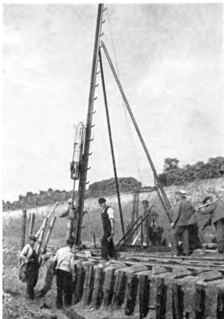
Abb. 54. Delmag-Pfahrramme mit Stativgerüst beim Rammen von Holzpfählen, Ø 20 cm, 3 m lang.
