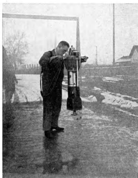
Abb. 210. Die Demag-Pflasterramme (100 kg, Type E) beim Abrammen von Kleinpflaster. (Demag, Eßlingen.)
