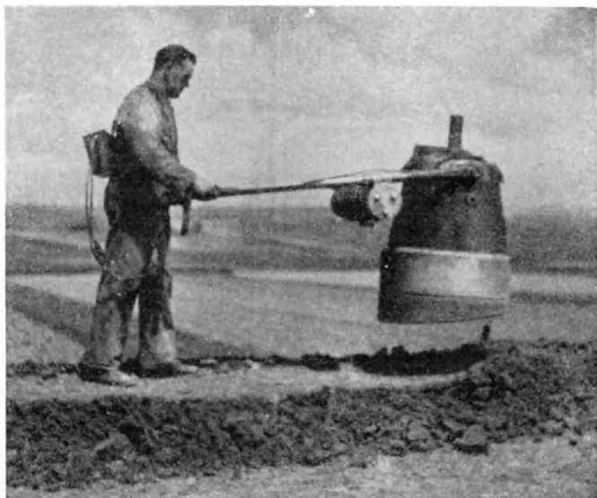
Abb. 25. Der Delmag-Frosch (1 t) während des Sprunges. (Delmag, Eßlingen.)
