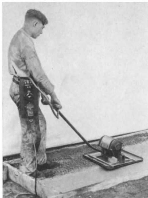
Abb. 39. Betonrüttler „Vibromax“. (Losenhausenwerk.)
