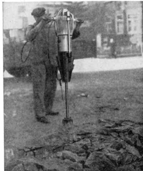
Abb. 18. Die Delmag-Meißelramme (100 kg, Type E) beim Aufbruch einer hartgefrorenen Straßendecke. (Delmag, Eßlingen.)
