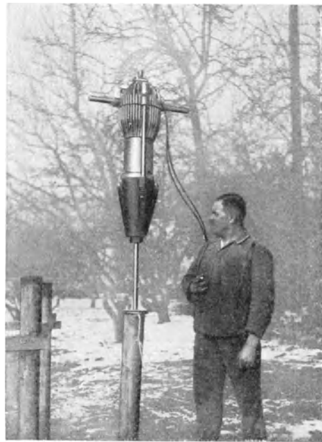
Abb. 53. Die Delmag-100-kg-Pfahlramme beim Einrammen eines leichten Holzpfahles. (Delmag, Eßlingen.)
