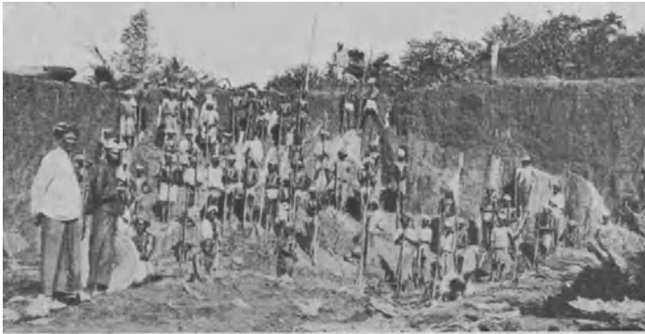
Abb. 3. Lösen des Seifenmaterials durch Eingeborene in Ostindien.
