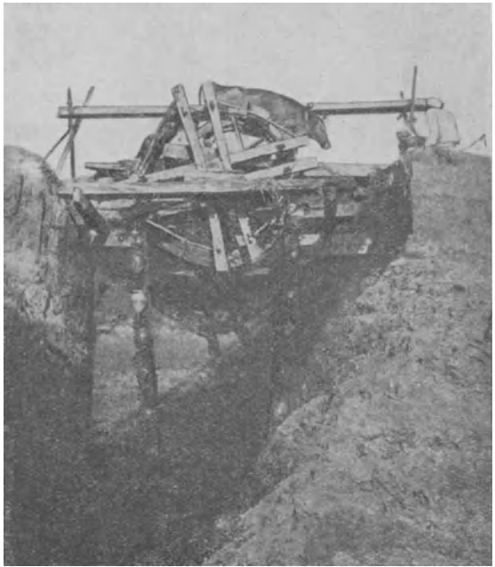
Abb. 10. Durch Göpel angetriebenes Schöpfrad.
