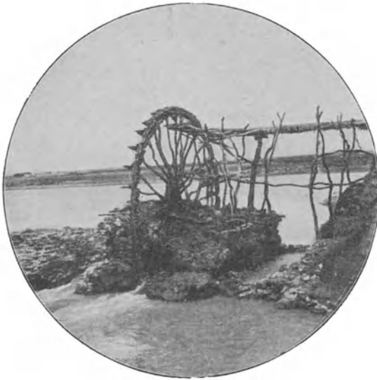
Abb. 5. Ein noch heute verwendetes Wasserrad aus Mesopotamien.
