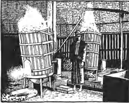
Abb. 5. Zinnschmelzöfen der Eingeborenen in Ostindien.
