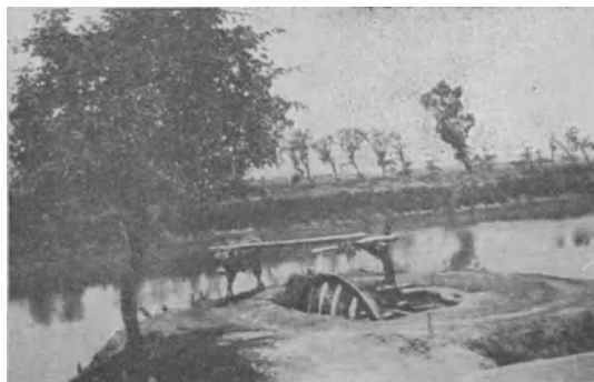
Abb. 9. Die Schöpfbecher sitzen bei diesem Göpelwerk unmittelbar am Radkranz.
