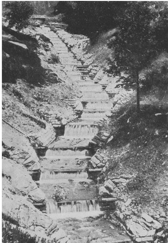
Abb. 103. Beispiel einer Verbauung aus Holzsperrn mit Steinflügeln.
