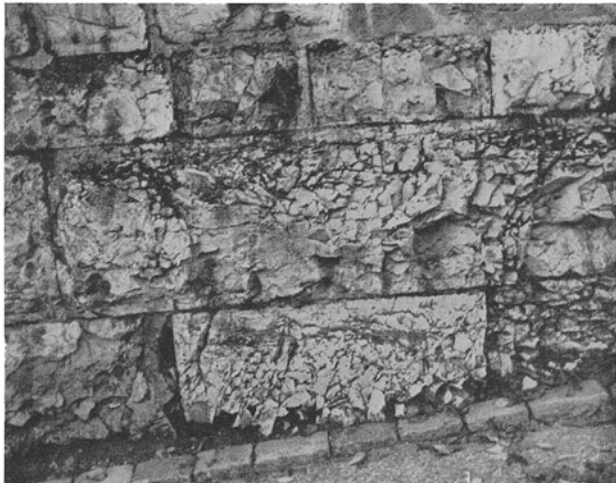
Abb. 200. Zerstörung von feinkristallinem, sprödem und dadurch beim Bearbeiten rissig gewordenem Kalkstein. Typische Zerbröckelung durch Frost.
