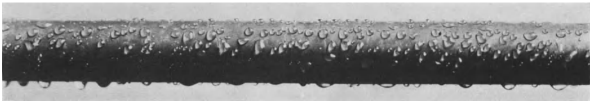
Abb. 100 ( \frac{3}{4} natürlicher Größe). Die beim Abpressen des in Abb. 99 gezeigten, durch chemische Entzinkung korrodierten Rohrs entstandenen Wasserperlen lassen die siebartige Durchlöcherung der Rohrwand erkennen (s. S. 67).
