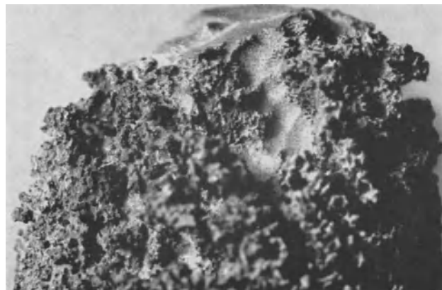
Abb. 77 ( V = 2 ). Kraterartige Korrosionen an dem pumpenseitigen Wellenende (Abb. 74) (s. S. 51).
