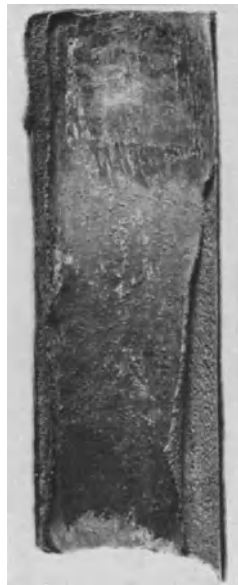
Abb. 55 (natürliche Größe). Schichtenweise Kupferablagerung an einem korrodierten Messingrohr der Legierung 70/29/1 (s. S. 32).
