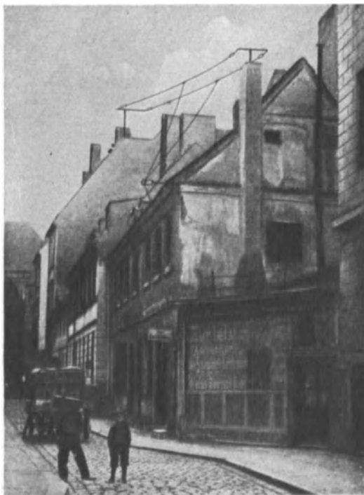
Abb. 560. Antenne bei einem eingebauten Haus.
