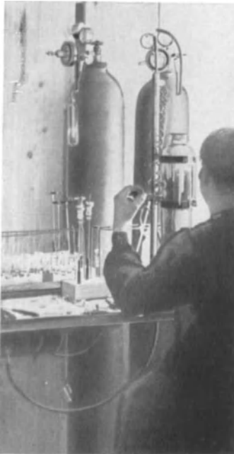
Abb. 383. Einziehen des Heizdrahtes in das fertige Füßchengestell.
