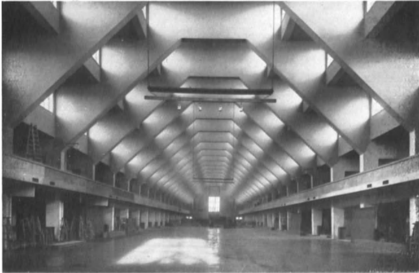
Abb. 15. Inneres der Messhalle der Deutschen Funkausstellung Dezember 1924 in Berlin während des Bauzustandes
