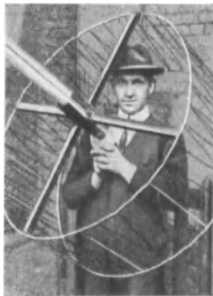
Abb. 563. Reusenförmige Endkapazitätsantenne.
