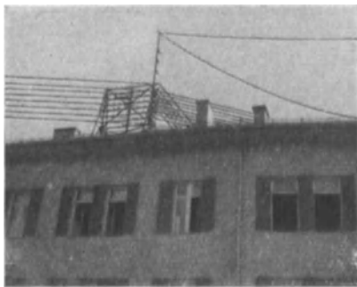
Abb. 562. Ungünstige Antennenanordnung zweier ungenügend isolierter fest miteinander gekoppelten Antennen.
